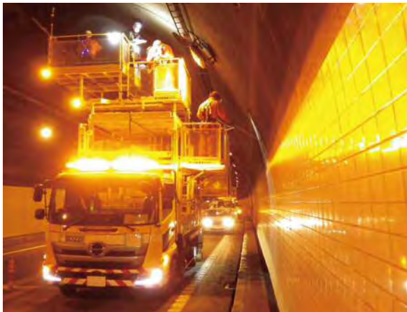
E-マルチ点検車使用状況 前面
