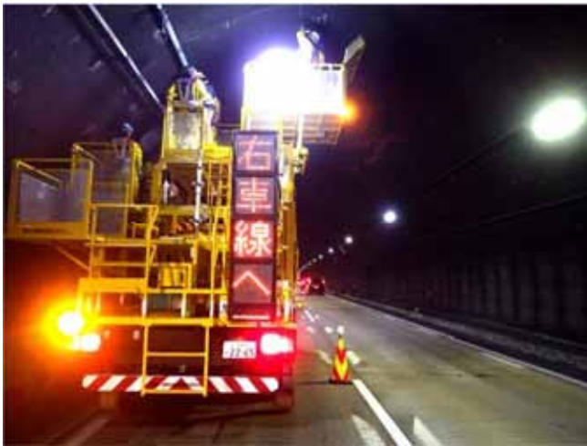
走行側 作業時
