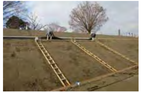
天端コンクリート工との取り 合い部: 端部止水シート設置
