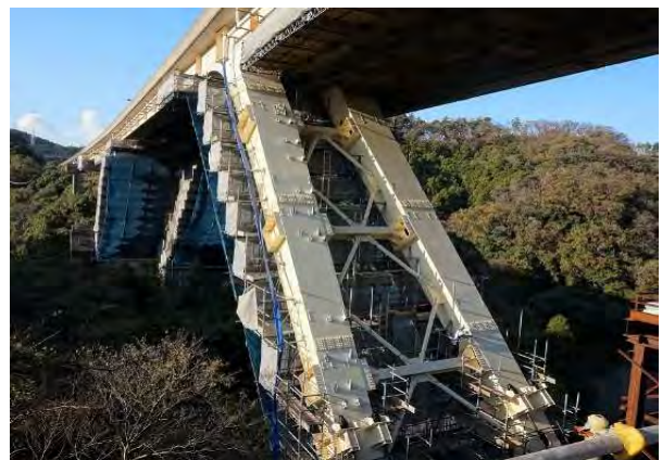
田浦第二高架橋(全景)
