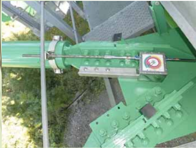
累積変位記録計の設置状況（太田切川橋梁）
