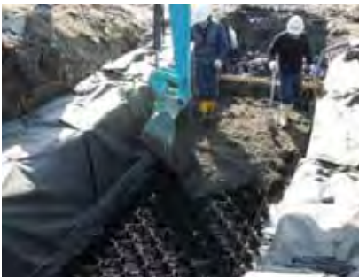
7. 中詰材撒き出し状況
