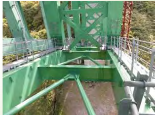
二重鋼管ダンパー設置状況
