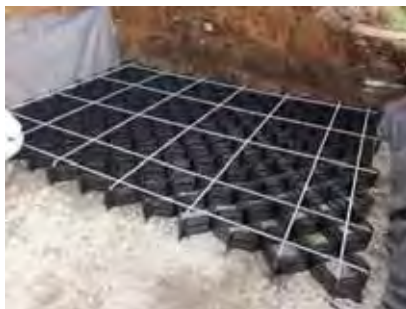
5. ジオセル敷設状況(鉄筋治具)
