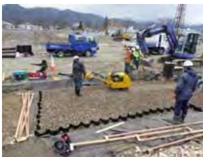
10. 転圧(振動ローラー)状況
