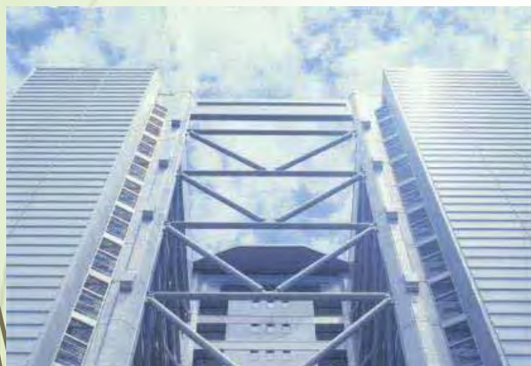
二重鋼管座屈拘束ブレース
