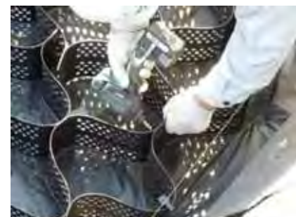
6. ジオセル接続状況(タッピングビス)
