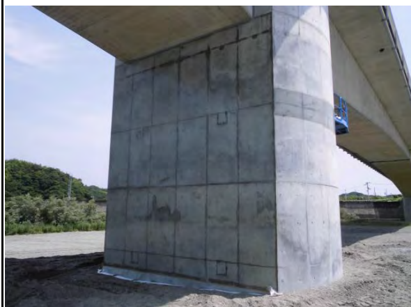
—塗布後状況写真—
