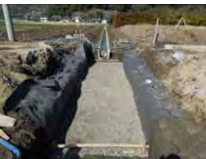
11. 中詰材転圧完了
