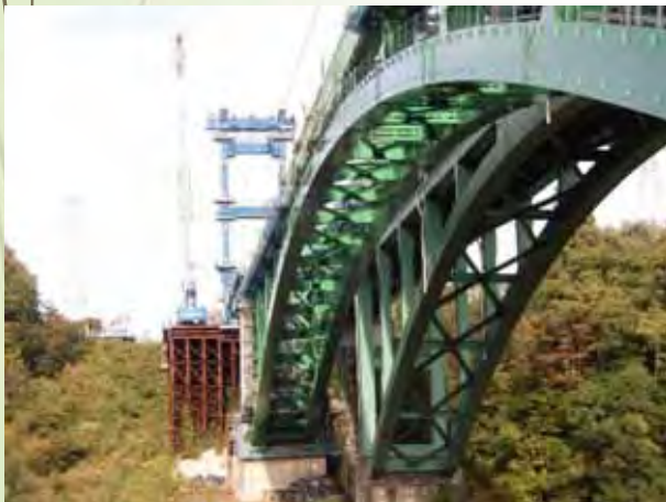
太田切川橋梁 (全景)
