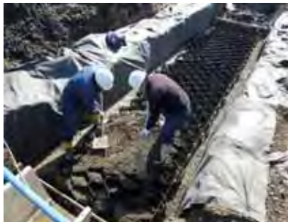
8. 敷き均し状況
