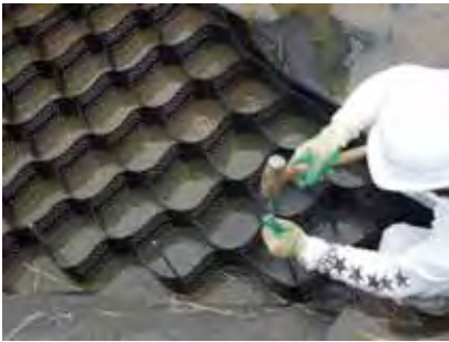
4. ジオセル敷設状況(鉄筋棒)
