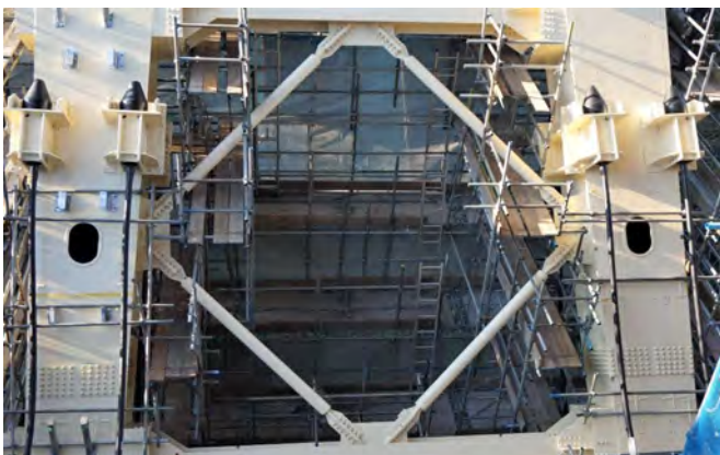
二重鋼管ダンパー設置状況
