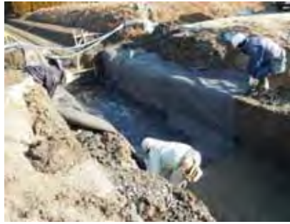
2. 吸出防止材敷設状況
