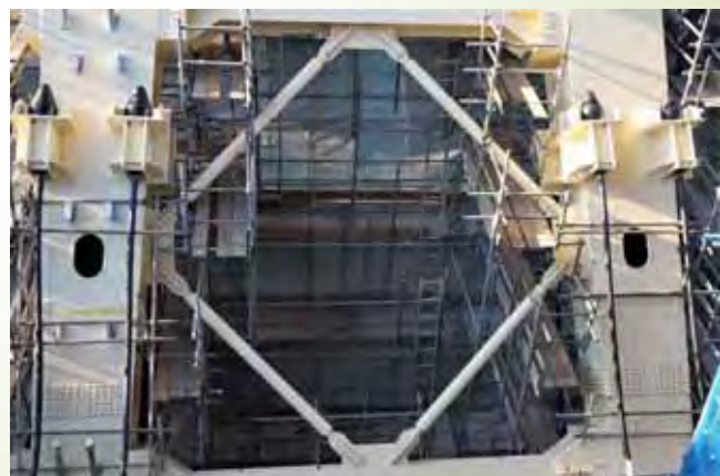
二重鋼管ダンパー設置状況
