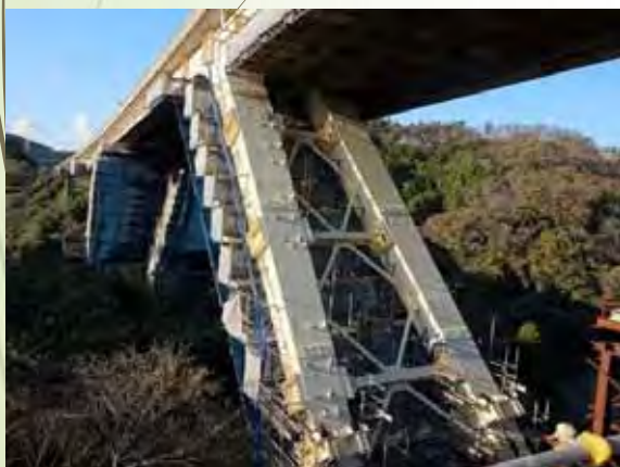
田浦第二高架橋（全景）
