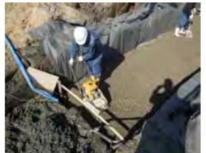
9. 転圧(振動コンパクタ)状況
