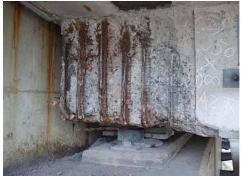
(左)：既設コンクリート道路橋桁端部の腐食環境改善への取組み(土木技術資料 55-11(2013))
