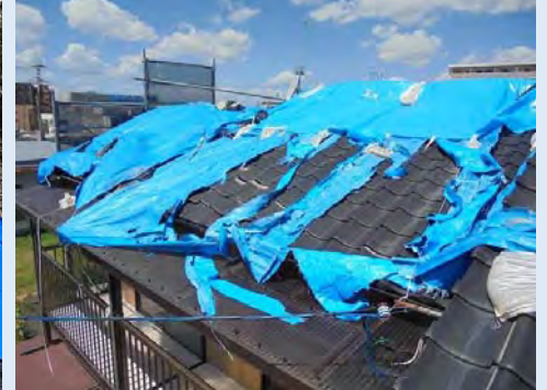
屋根の保護シート
