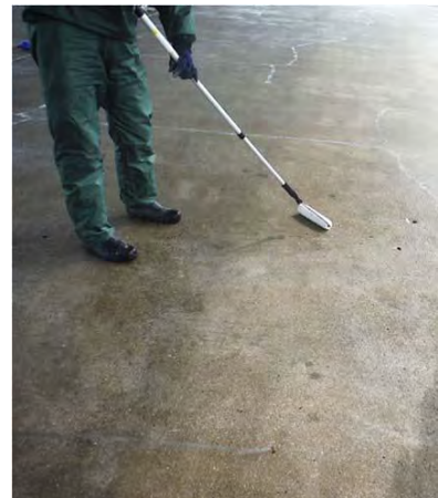
ローラー塗布状況
