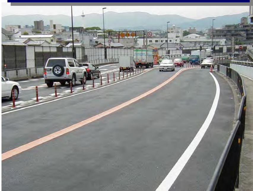
京都府内 国道1号線 高架橋 交通量約60,000台／日
