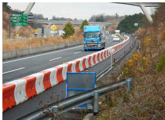
写真-2 設置状況①
