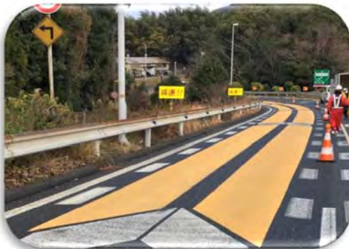
写真-5 インターチェンジランプ
