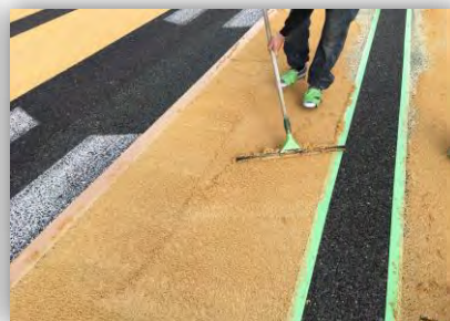
写真-3 モルタル敷設
