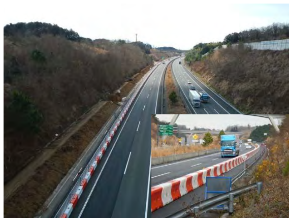
施工延長 約2,600m
