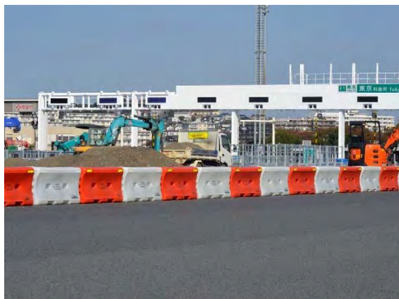
施工延長 約600m
