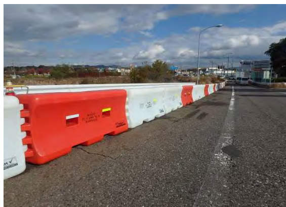
写真-3 設置状況②
