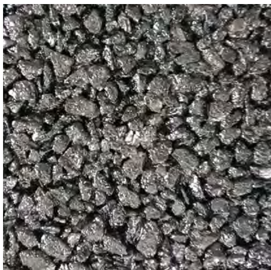
ポーラスアスファルト舗装
