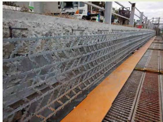
護岸の補修工事
