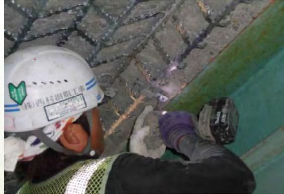
④固定金物・アンカーによる取付作業
