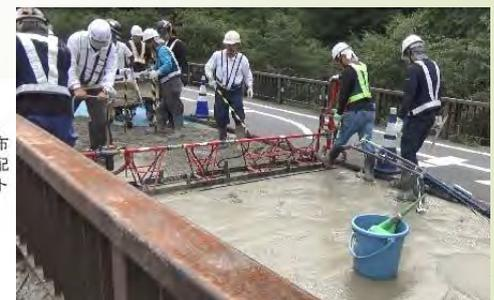
超速硬コンクリートの打設
