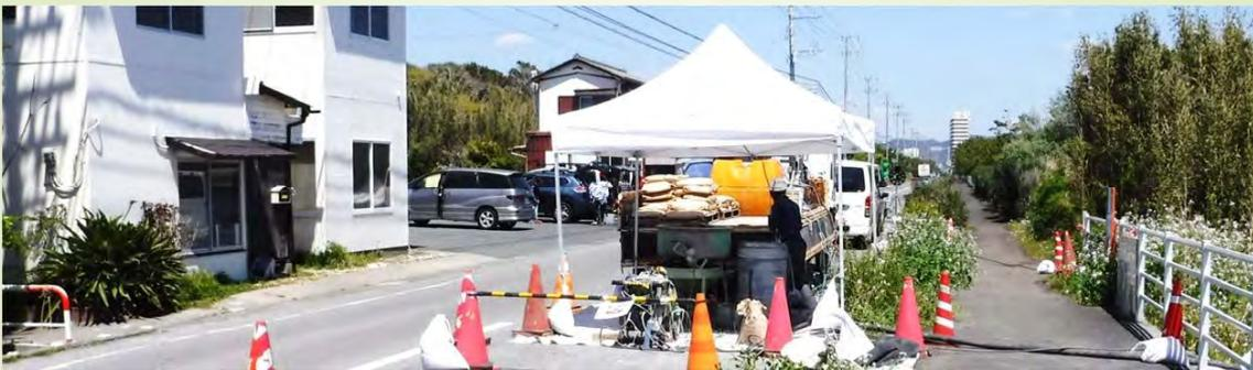
①モルタル吹付け機材（道路は片側一車線規制 常設）
