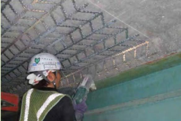
③電動ドリルによる削孔作業
