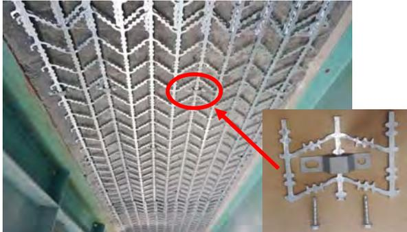
①RC床版下面のグリッドメタル設置完了状況
