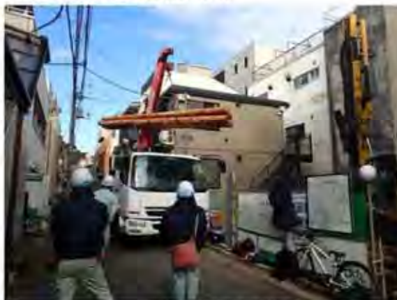
狭小地での丸太搬入状況
