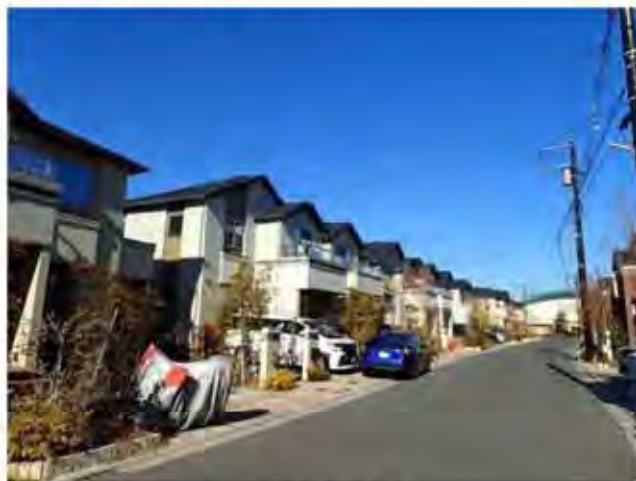
完成後の状況
