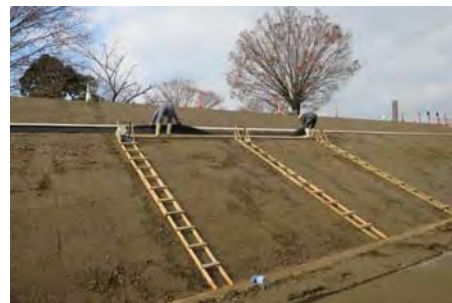
天端コンクリートとの取り付け部: 端部止水シート設置
