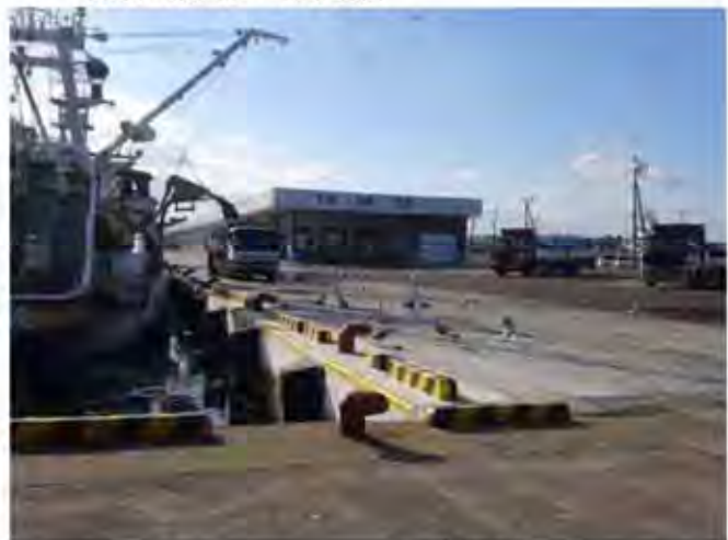
完成後の状況
