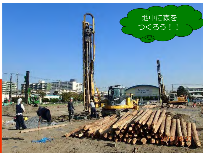
LP-LiC工法の施工の様子
