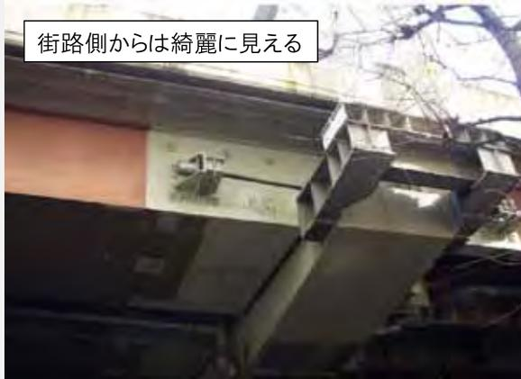
内桁側の一部で、局所的な漏水が原因で腐食
