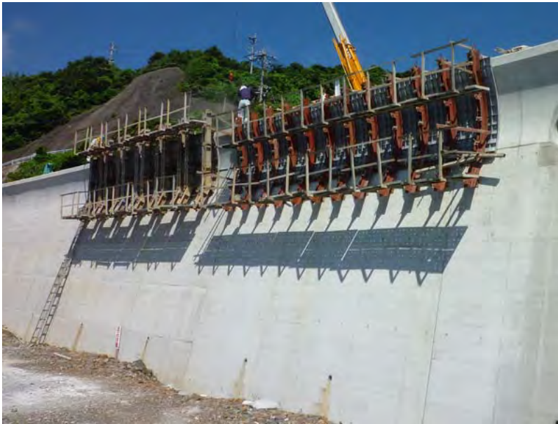
セパレス工法 状況写真
