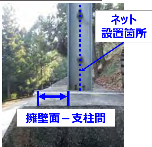
【既存構造物と落石防護柵】
