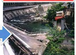
新管橋 (ボステン外ケーブル式PC箱桁橋, 橋長26m), 1965年竣工, 1989年落橋
