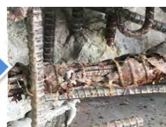
鋼材の劣化/破断
