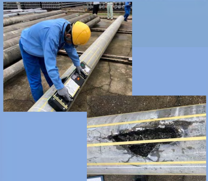
電柱（被雷した電柱の健全度確認）
