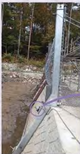
支柱設置状況
