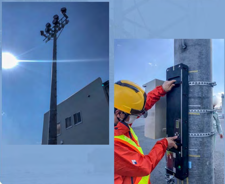
投光器（ダンプカー衝突後、健全度確認）
