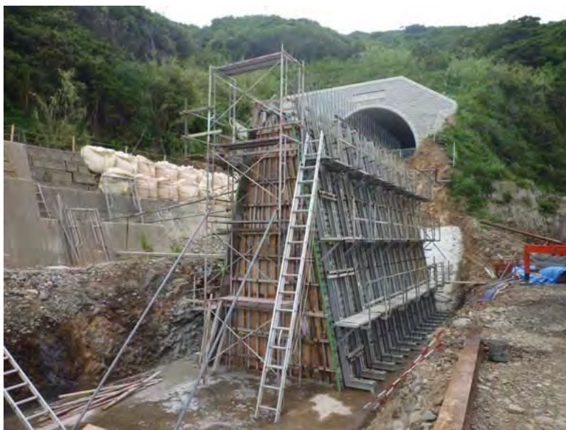
セパレス工法 状況写真
