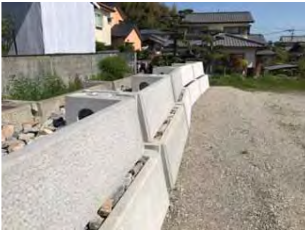
凸カーブ (R-45M)手前～凹カーブ (R-45M)奥
