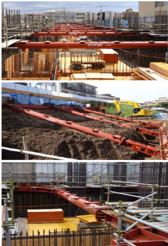
円形鋼管切梁「Circular Strut」設置例
