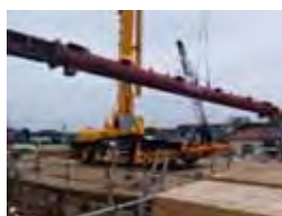
大型車両で部材搬入するため搬入経路の確保と揚重クレーンの選定には十分留意する必要がある。
