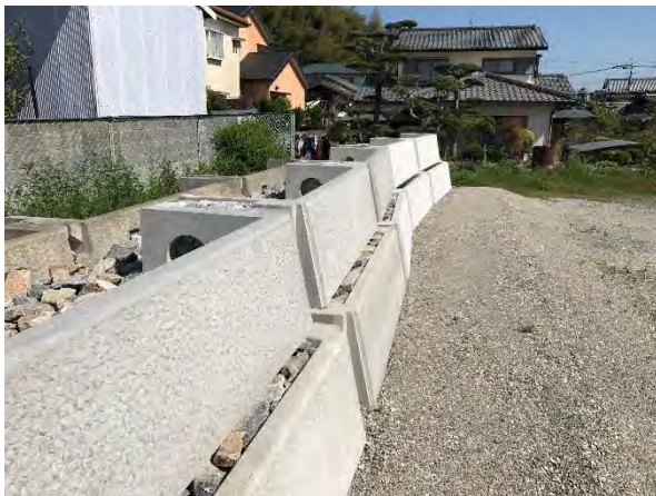
凸カーブ(R-45M)手前～凹カーブ(R-45M)奥
