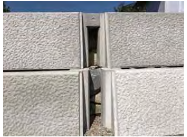
凸カーブ におけるブロック側壁間の開き
