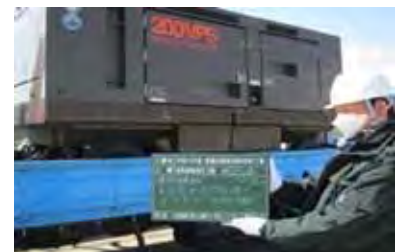
コンプレッサー
