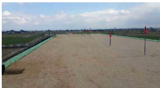
写真-2 施工1年後の盛土天端状況
