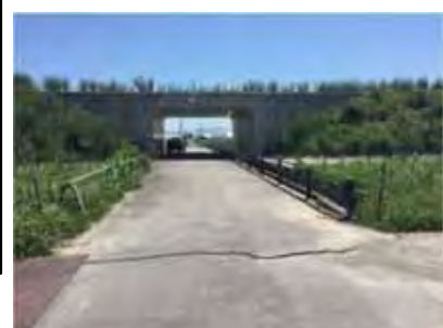
熊本地震後の盛土
