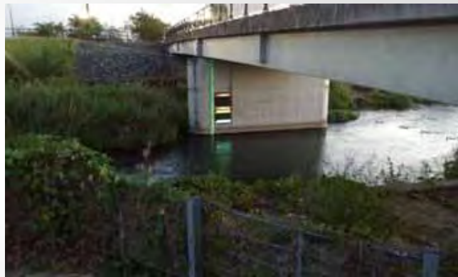
福岡県土事務部 南筑後県土整備事務所 柳川支所管内松原橋 設置
