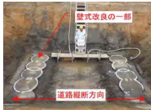
写真-1 横断壁の施工状況
