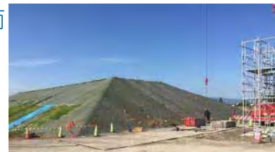
(a) 盛土法面
