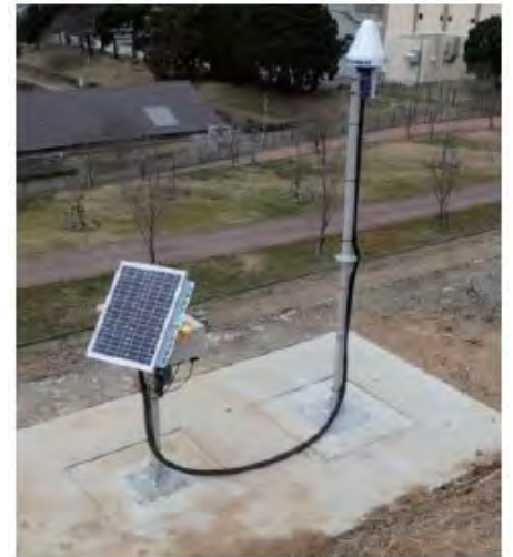
写真1. shamen-netシステムの設置例
