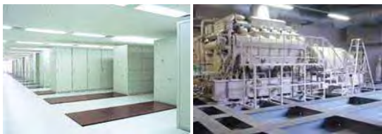
自家発電装置およびサーバーセンター概要
