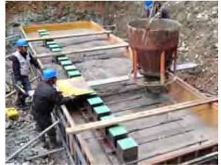
①底版コンクリート(1次)打設 ②底面通し材・基礎鞘管の設置 ③底版コンクリート(2次)打設
