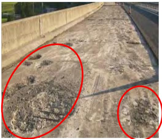
写真-1 繰り返し荷重で剥離・土砂化したコンクリート床版
