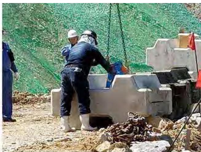
新工法（コマチェーンバランサーとコマクランプを使用した玉掛け索）
