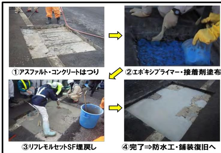
写真-2 床版補修の手順(①～④)
