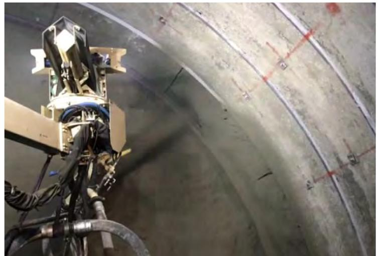
Spraymec8100VCによるコンクリート吹付作業
