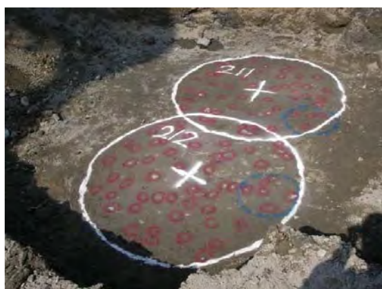
既製杭破碎出来形状況
