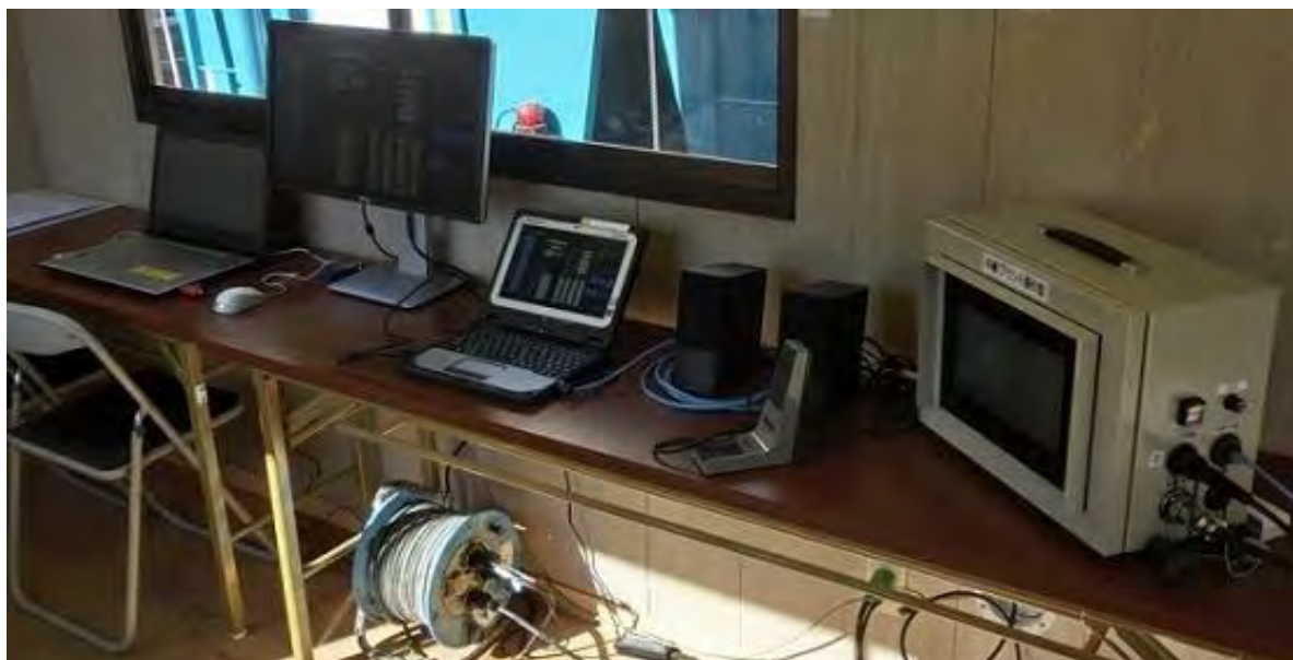
計器設置状況
