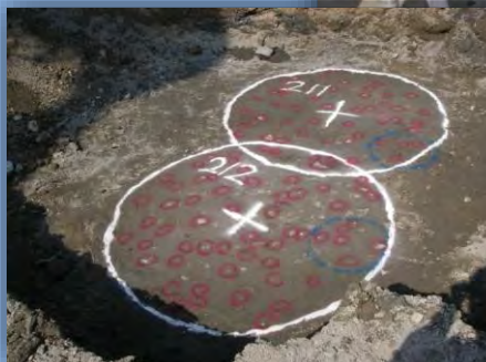
杭破碎同時施工
