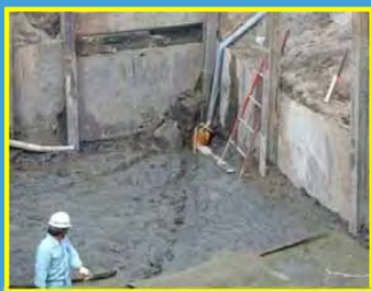
ポンプによる釜場処理
