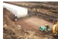
Fe石灰処理土 の転圧
