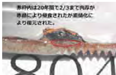
赤錆を黒錆に変え管を還元する
