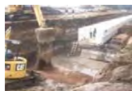
Fe石灰処理土 の搬入
