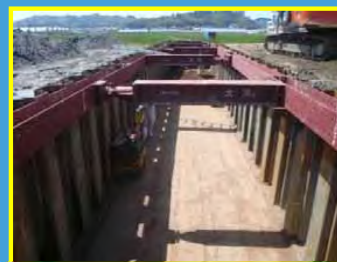
鋼矢板による遮水処理
