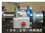
◎本体と配管の絶縁確認
