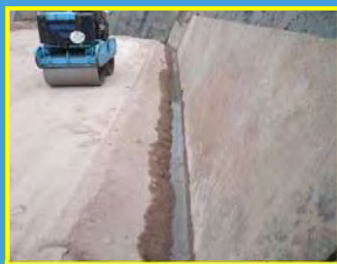
溝切りによる排水処理
