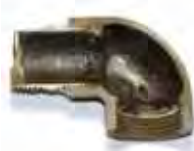
黒錆皮膜が管壁を覆っている（設置後10年）
