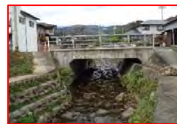
ボックスカルバートの基礎
