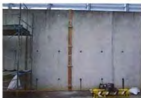
①型枠組み立て
