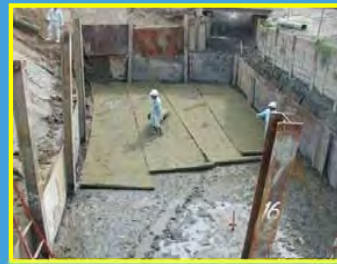
土木シートによる練返し防止対策
