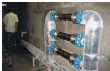
駅ビル施工例
