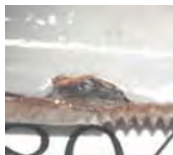
赤錆を黒錆に変え管厚を復元する
