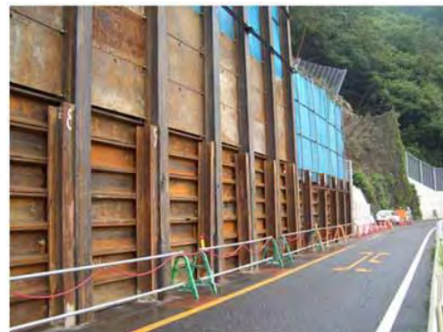
広島市安佐北区役所 農林建設部維持課 様 一般国道191号災害復旧工事
