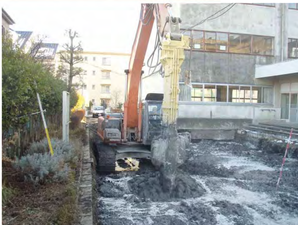
特殊攪拌工法（スラリー）
