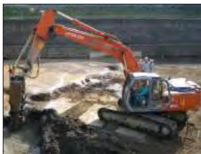
写真 トレンチャー(スラリー)
