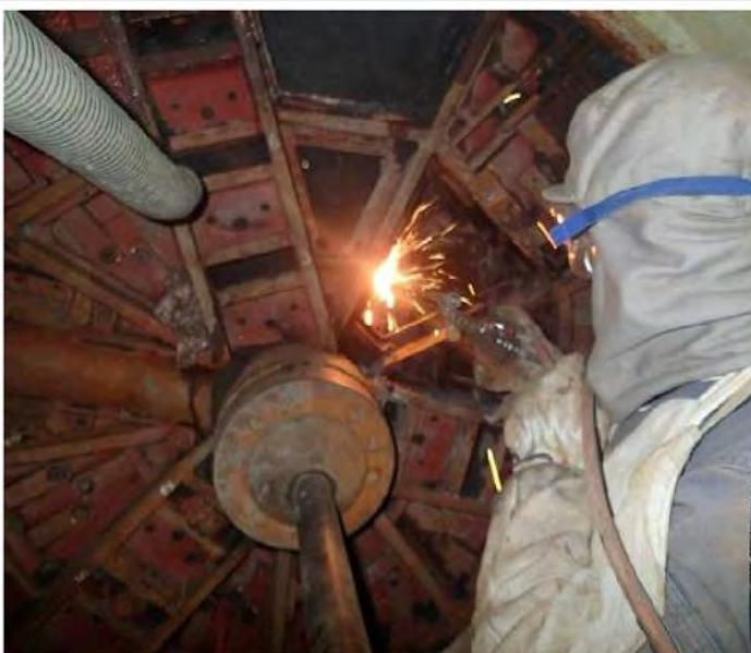
H形鋼切断状況
