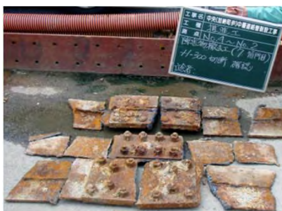
写真-5 切羽で切断・回収された鋼材
