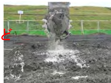
サイトA(施工時)
