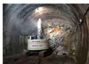
トンネル掘削工事
