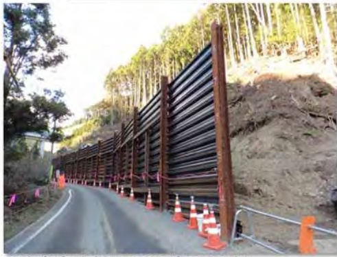
中日本高速道路(NEXCO中日本) 様 中部横断自動車道湯沢工事前道路工事 (LSP-3B 270枚 とまった君2号 586個)
