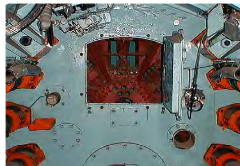
写真-4 「点検扉」の開放
