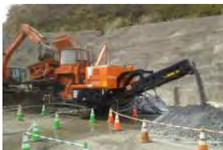
写真 自走式改良機(粉体)
