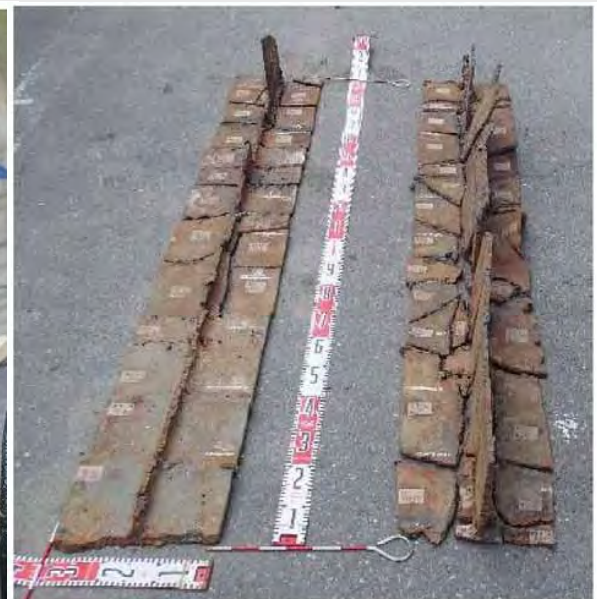
撤去されたH形鋼
