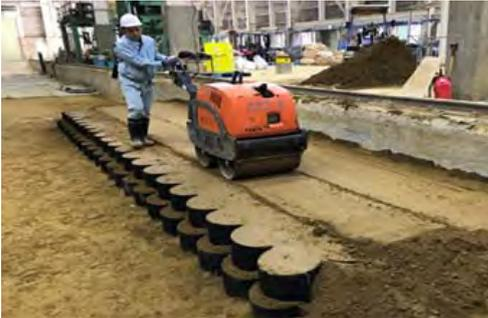
写真-1 ジオセル内外の確実な締固め
