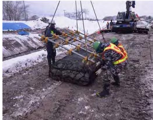
適度な剛性があるため、カゴとして自立するが、柔軟性を残しているため地山になじみやすい。さびなど腐食にも強い。
