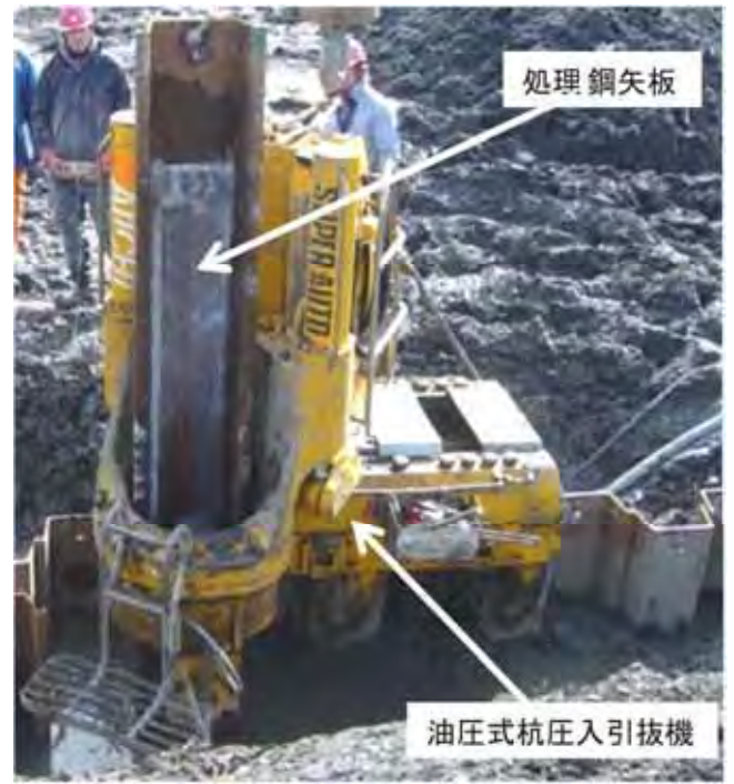
油圧パイラーで圧入打設
