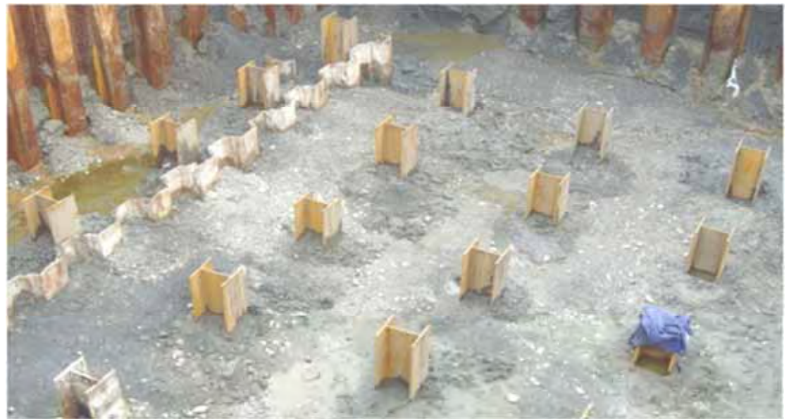
バイブロハンマーで圧入打設
