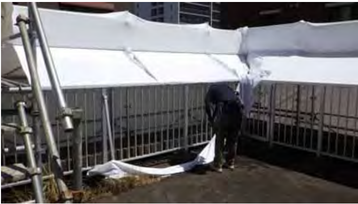
フィルム設置状況
