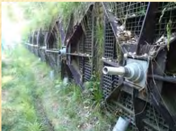
施工後 3年経過したアンカーの状況 (グリスを用いず腐食なし)
