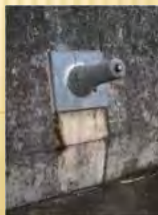
背面水の作用した痕跡
