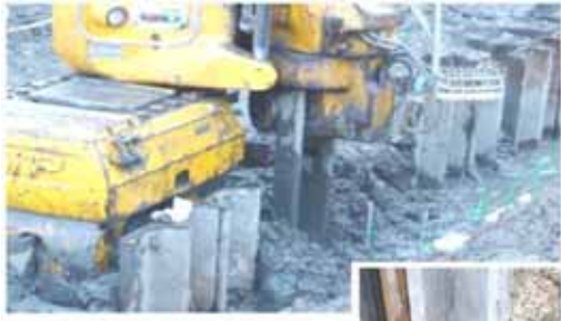
土留め鋼矢板
