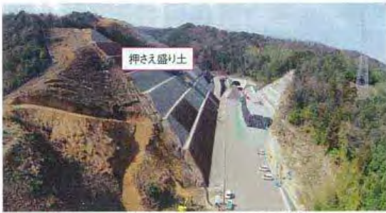
写真2 ■ 変状が生じた重山地区の法面。2018年2月末撮影
