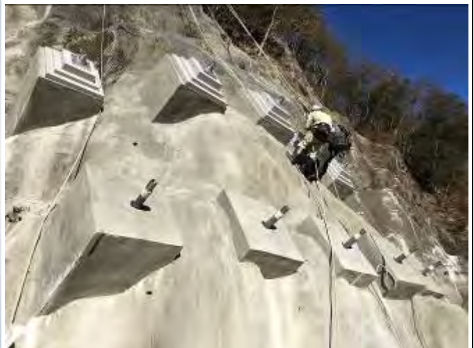
施工事例 (高所の岩盤崩壊対策)
