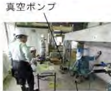
②LBD-B1による小径削孔 ③シース内の空洞量推定 ④切換え式グラウト注入ポンプ
