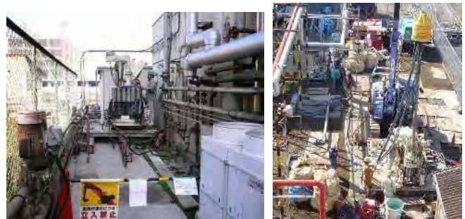
マルチジェット施工状況
