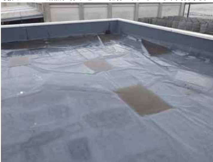
下地と断熱材のはく離による防水層の破断
