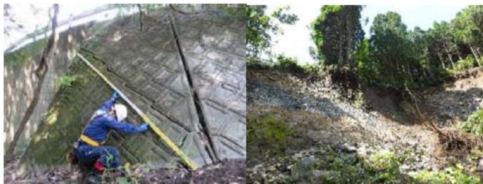
写真7 斜面の崩落
