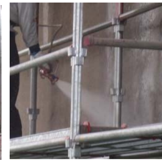
エアレススプレー施工
