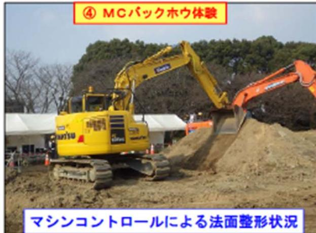
自動整地アシスト制御により自動で法面を整形できます。
