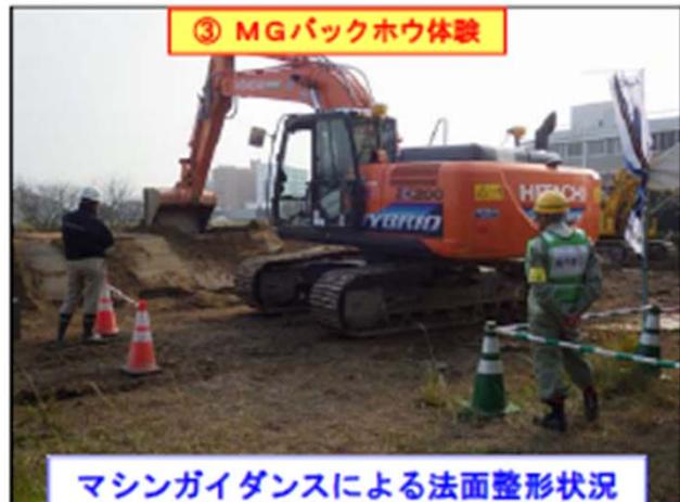
ガイダンスに従ってバケットを動かすことで法面が整形できます。
