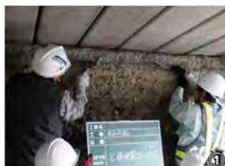
① コンクリート面の清掃
