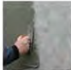
下地調整 - コンクリート (工事現場)
