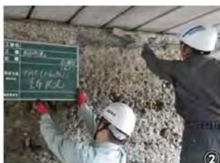
② プライマー処理
