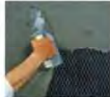
下地調整 - ラス下地 (一般住宅)
