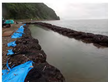
▲新潟県 仮設消波工（3t 型使用）
