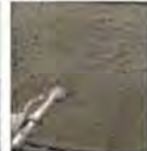
下地調整 - コンクリート (工事現場・吹付)
