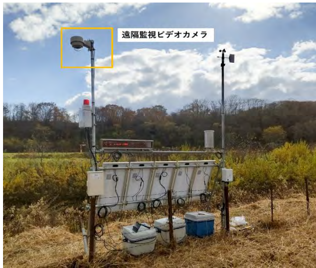
図ー５ オプション施工方法② 遠隔監視ビデオカメラ・太陽光電源装置
