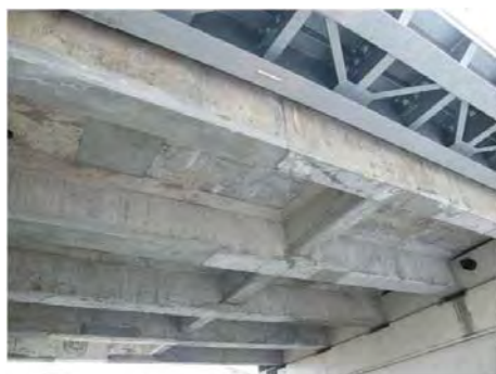
施工例 (床版下面の補修)
