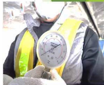
⑤ 注入完了 タレ防止のためPHI(注入)パイプ及びPV(吸引)パイプをおり曲げる
