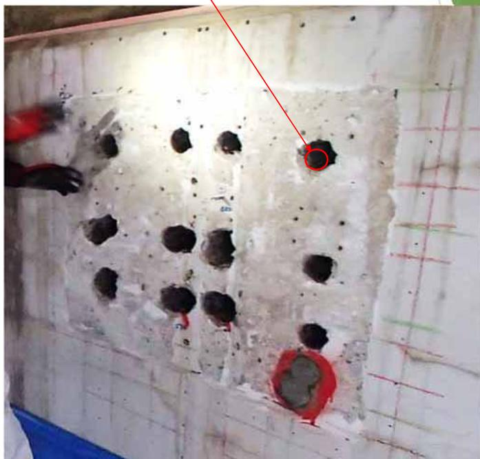
通常のコア削孔穴とウォータージェット穴では注入量が(設計の6倍必要)程度違います。
