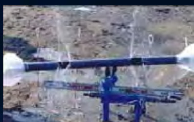
注入外管吐出状況
