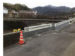
ガードレール取付け
