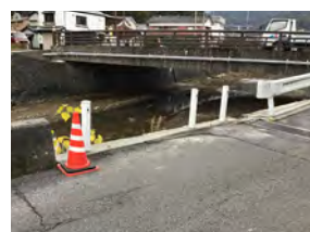
均しモルタル
