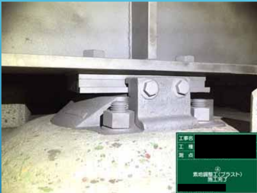
▶ 素地調整1種(ブラスト)完了
