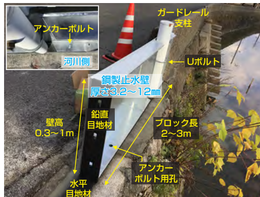
アンカー式鋼製止水壁の概要（左：断面図、中：側面図、右：施工写真）
