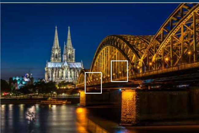
インフラ関係：橋梁
