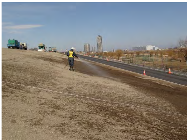
1パッチの散布範囲を決め、2L/m 2 を散布します。
