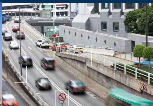
道路関係：交通標識・照明・ガードレールなど
