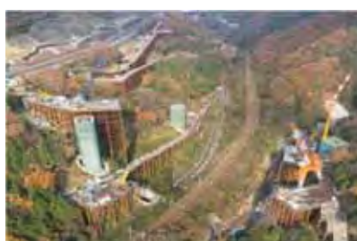
SqCピア工法鋼管棧橋 和歌山県 京奈和自動車道ジャンクション工事
