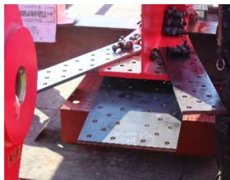
②プレート設置
