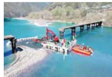
組立式自航艇 高知県 四万十岩間沈下橋補修工事
