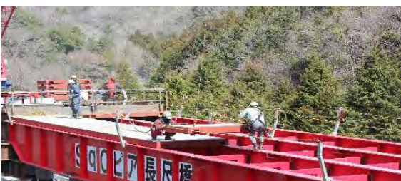
⑨覆工板敷設
