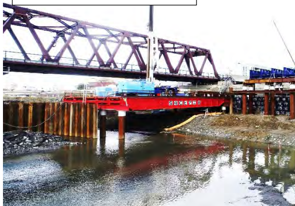
中部地方 橋長20m
