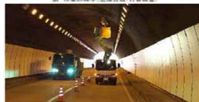
図 作業の様子(高所作業車)
