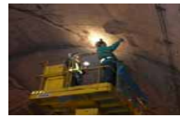
高所作業車での近接目視の様子
