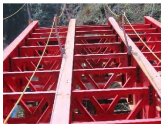
⑧対傾構架設
