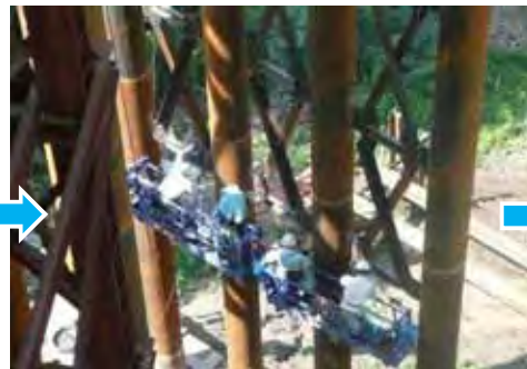
⑤ワンタッチ伸縮梁取付 (ゴンドラ作業)
