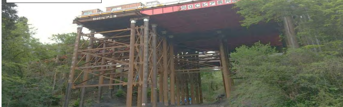
中部地方 橋長20m
