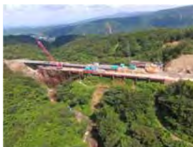
SqCピア工法 鋼管棧橋 熊本県 熊本地震災害復旧工事
