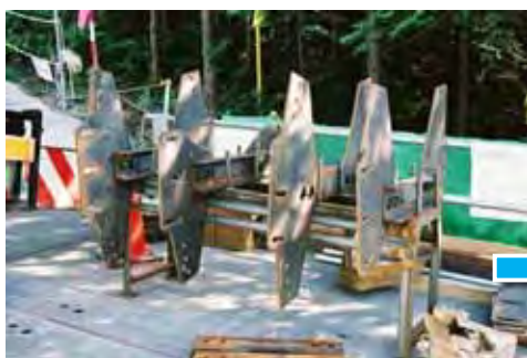
①工場製作部材搬入
