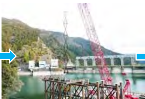
④ワンタッチ伸縮梁吊込み
