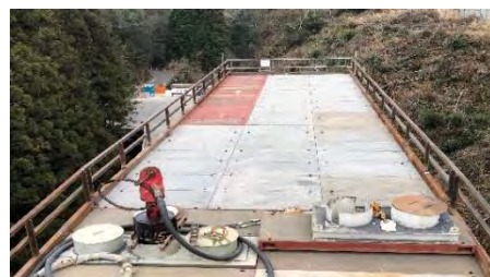
⑩手摺り設置
