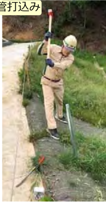
①単管打込み
