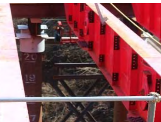
⑦主桁架設
