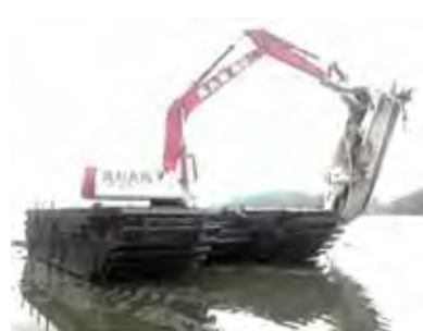
水陸両用泥上車 宮城県 松島震災復旧工事 経済産業大臣より表彰
