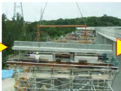
②PCa桁をPCa横梁に架設
