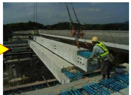
④連結部にコンクリート打設
