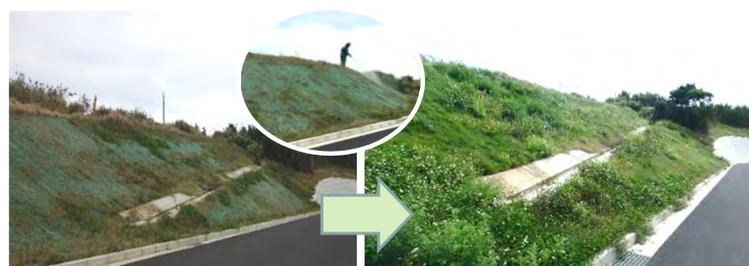
植生生育不良の植生シート工の上から施工して、検査に合格する十分な植生形成を行った例
