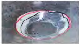
【ボンド KEEPメンテ工法 VMクリア】は、コンクリート表面に透明なポリウレタン樹脂を塗布することによりコンクリート片のはく落を防止する工法です。
