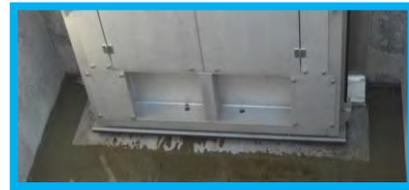
図1 従来の既設極門の無動力自動化改修
