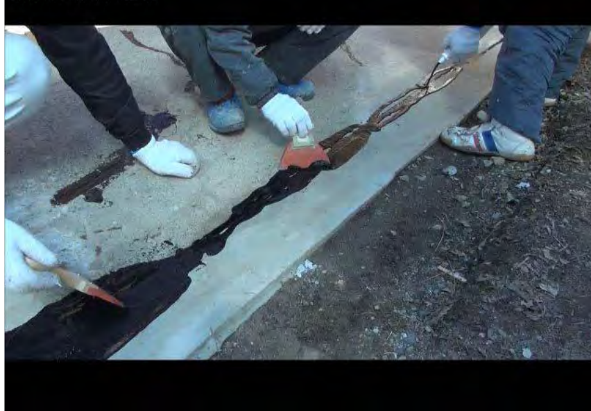
JOINTの床版面塗布
