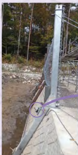
支柱設置状況
