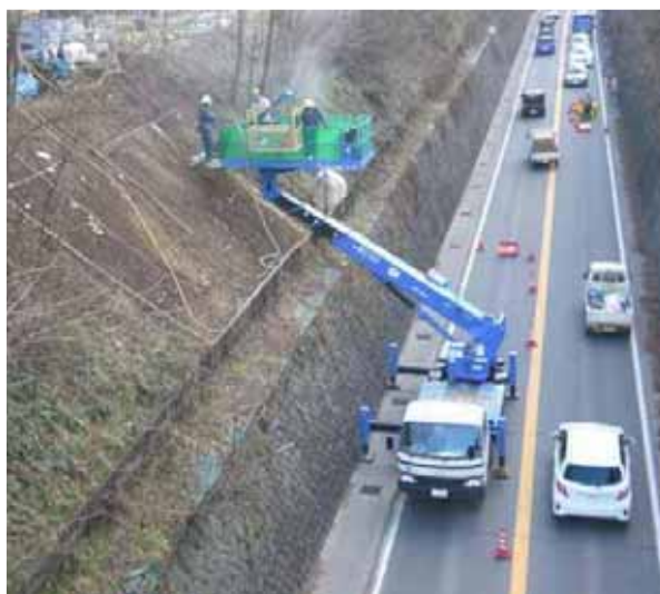
削孔作業に高所作業車を使用する例
