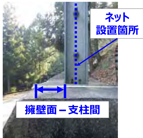
【既存構造物と落石防護柵】
