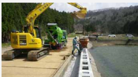
笠コン施工状況
