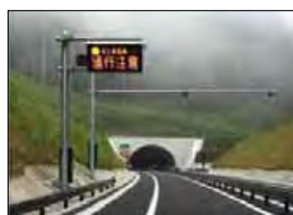
東北地方整備局 南三陸沿岸国道事務所 2018年3月納入
