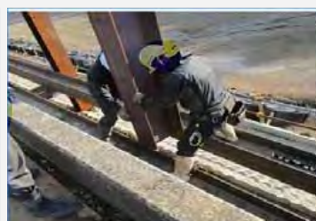
親杭（H形鋼打設状況
