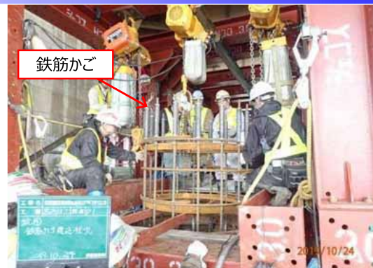
鉄筋かご建て込み状況
