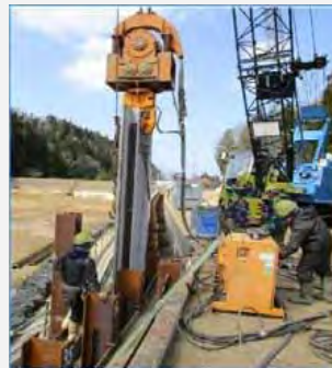
コンクリート板打設状況
