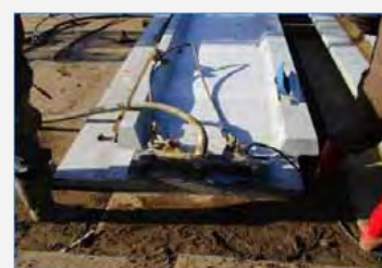
ジェット管取付
