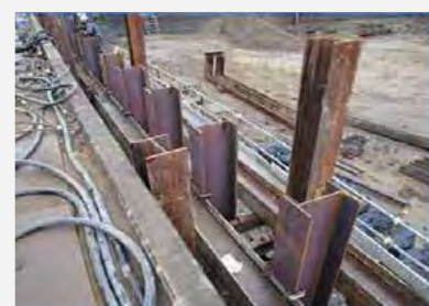
親杭打設後（コンクリート板打設前）
