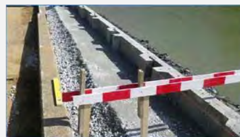
背面埋め戻し後（笠コン施工前）
