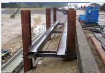
導枠セット状況
