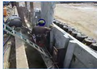
コンクリート板打設状況（背面側）
