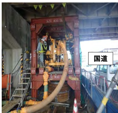
写真1: 国道近接での施工状況
