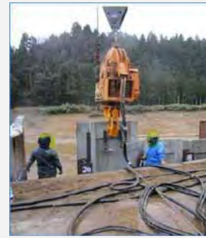
コンクリート板打設状況（背面側）
