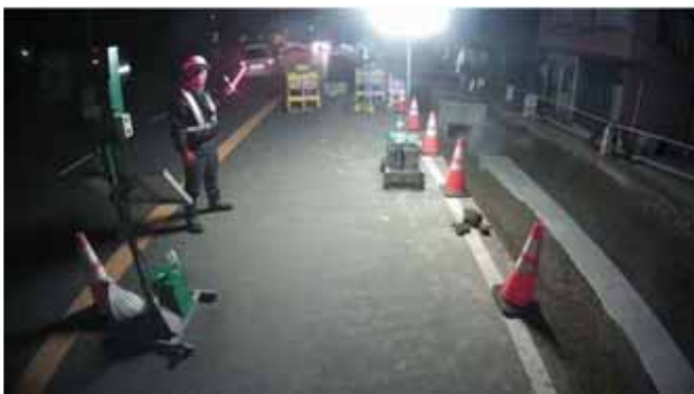
工事現場の遠隔監視
