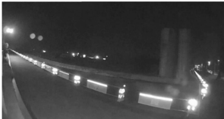
工事現場(夜間)の遠隔監視
