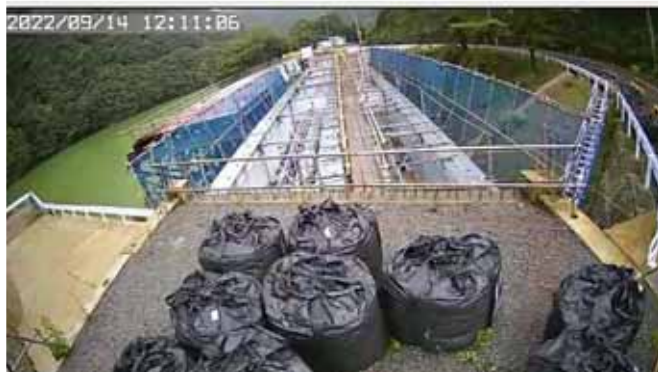
橋の施工状況監視
