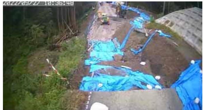
道路の拡張工事状況監視
