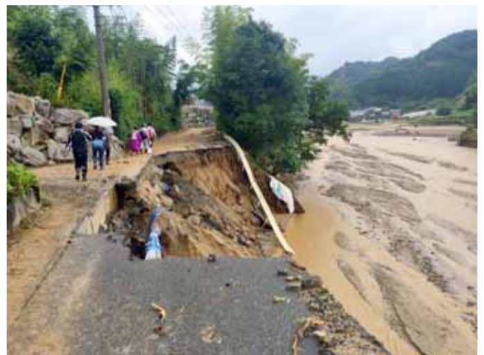
災害時の現場監視
