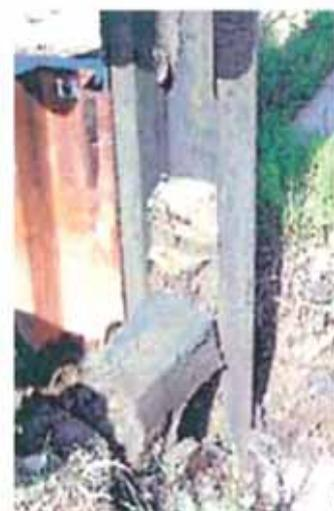
鋼矢板撤去による抜き孔に近接地盤が陥没する
