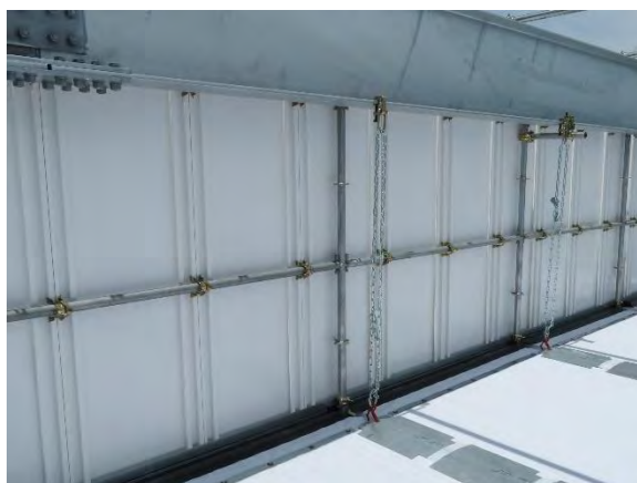
脱着を容易にする専用クランプ施工
