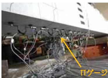
ひびゲージの設置状況
