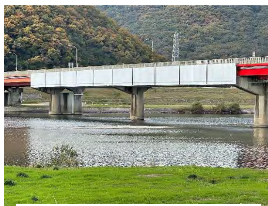
連結レール式PVC製防護柵使用現場写真
