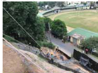
日本式の人力施工技術を海外に移転する場合も有り
