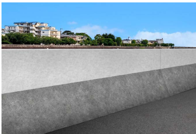
コンクリート壁による嵩上げ
