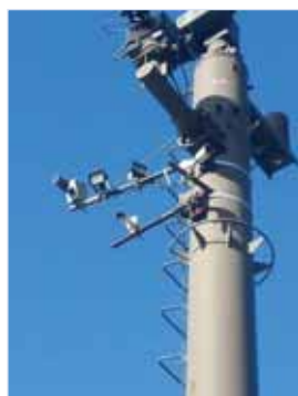
カメラ設置状況（現場）
