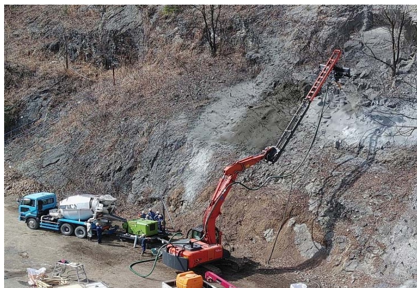
図-2 モルタル吹付状況
