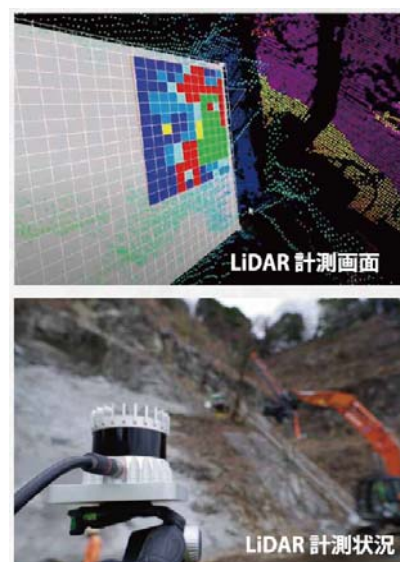
図-3 LiDARでの吹付厚計測
