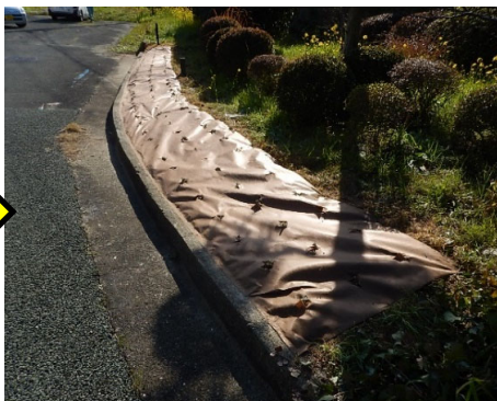
▼令和2年2月下旬 モデル施工実施
