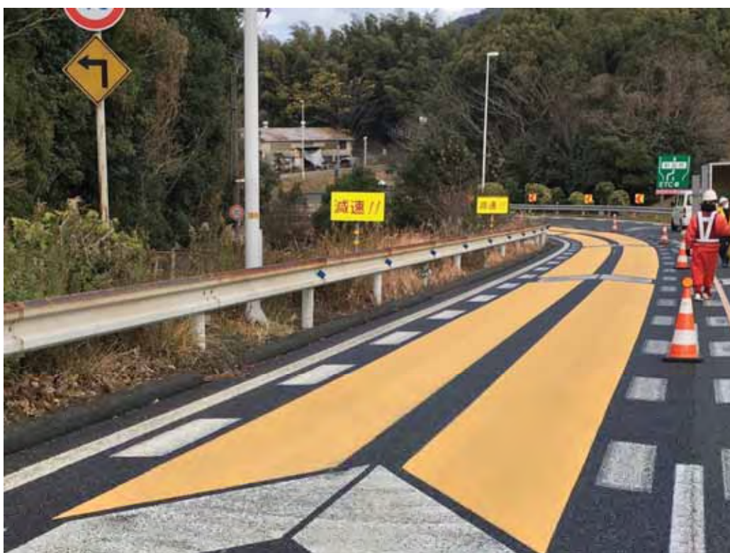
下関インターチェンジ ランプ部
