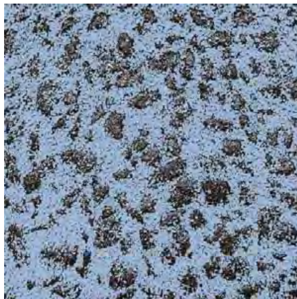
PRMS工法 青色骨材使用
