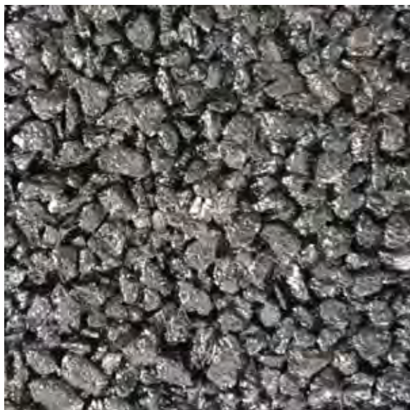
ポーラス アスファルト舗装
