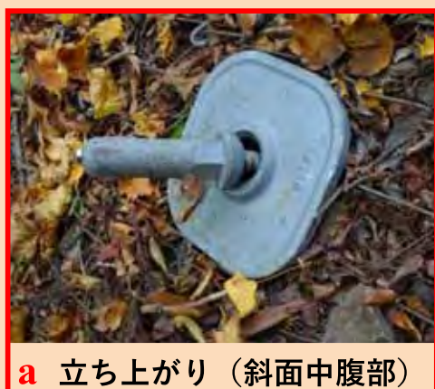
補強材の位置 と 変位状況の関係
