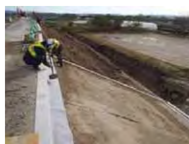
③ゴビマット遮水原反をコンクリートに接着
