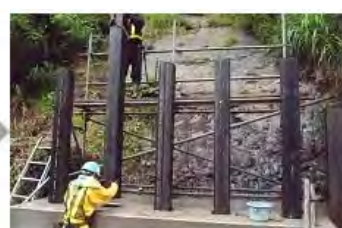
3. 鋼管柱の建込み 鋼管柱を基礎鞘管に建て込みます。
