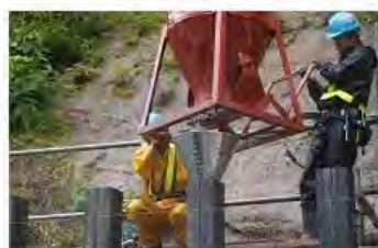
4. 鋼管柱内部コンクリート打設 鋼管柱内へコンクリートを充填します。空隙がないようバイブレーターを使用し鋼管柱天端まで打設します。
