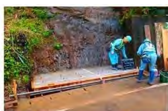
1. 底版コンクリート(1次)打設 基礎鞘管の設置基面まで、底版コンクリートを打設します。
