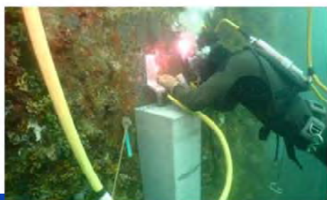
水中溶接作業の様子
