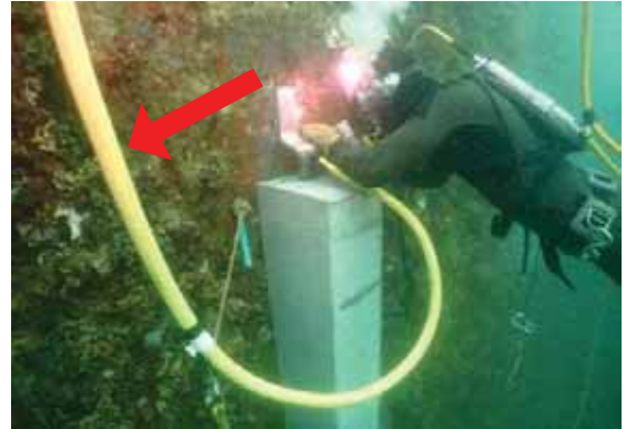
新方式（水中溶接用フロートケーブル）
