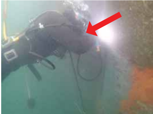
従来方式（水中溶接用ケーブル）
