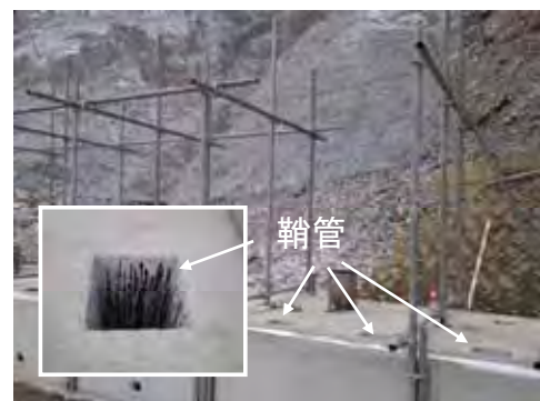
底版コン打設完了
