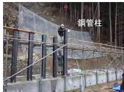
鋼管柱の建込状況
