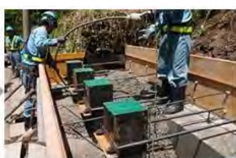
2. 基礎部の設置と(2次)打設 基礎鞘管を設置したのち、コンクリートを打設(2次)します。
