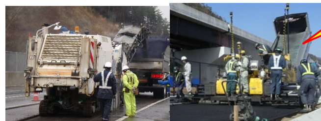
路面切削機等の施工履歴データ取得
