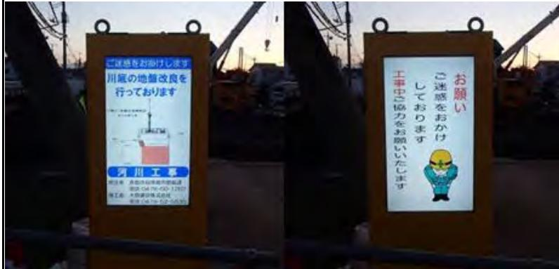
液晶パネルは 1200 カンデラの明るさで自ら発光します。昼夜を通じて見やすく、防犯効果も期待できます。工事標識の各種法令を適合した仕様で防塵防滴にすぐれ、どんな現場にも設置できます
