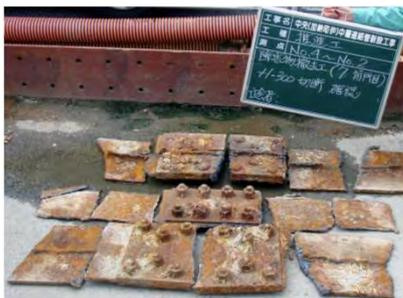
写真-5 切羽で切断・回収された鋼材
