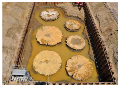
写真-2 掘り出された改良体
