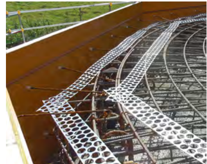
写真-3 風力発電所基礎への設置状況
