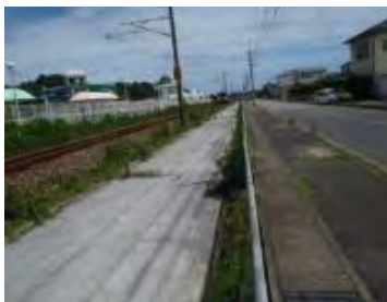
施工後1年8カ月経過 (平成25年8月撮影)
