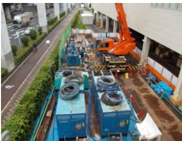
写真-1 施工状況
