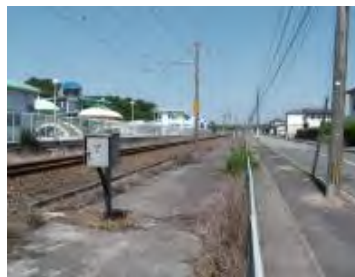
施工後5年6カ月経過 (平成29年6月撮影)
