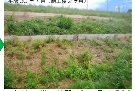
平成30年7月（施工後2ヶ月） 水中ポンプ施工箇所：2ヶ月でBSCの形成と旺盛な草本の侵入、成長を確認。
