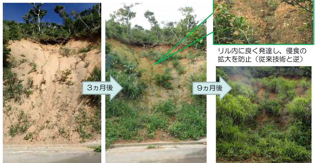
侵食防止及び植生侵入促進のため法面崩壊箇所に適用した例
