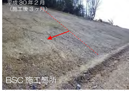
平成30年2月（施工後3ヶ月） BSC施工箇所 晩秋に砂礫質の法面に施工した例。冬季は植物の侵入・萌芽は見られない。
