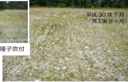
平成30年7月（施工後8ヶ月） 種子吹付 種子吹付箇所：散布種子（+飛来種子）や地表面の土が流失し発芽後も生育不良。
