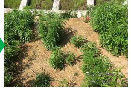
平成30年5月（施工後6ヶ月） 春季になり草本類の侵入が旺盛。BSCは薄い全面に見られ、侵食を防止。
