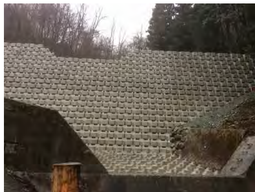
【えん堤補修工】
