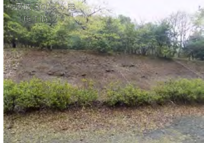
平成30年4月（施工時） 森林に囲まれた適度な湿度を保つ場所だが、植生侵入が無く、侵食が発生。
