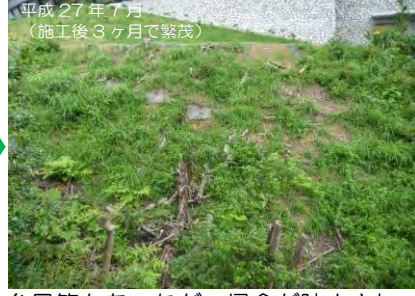
平成27年7月（施工後3ヶ月で繁茂） 台風等もあったが、侵食が防止され、種子が発芽して、早期に植生が回復。
