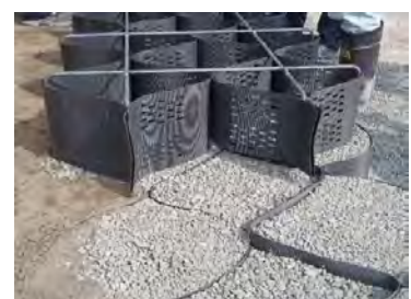
⑥アンカー筋打設
