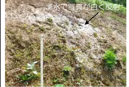
平成30年5月（施工後10ヶ月） 湧水で写真が白く反射 湧水により基盤に気相がない。水分過多のためBSC形成及び植生侵入困難。
