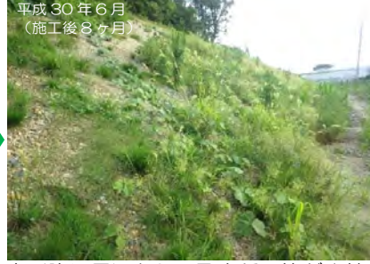
平成30年6月（施工後8ヶ月） 春以降に周辺からの飛来種子等が発芽。BSCは薄い表土が安定し生育良好。
