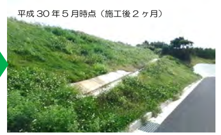
平成30年5月時点（施工後2ヶ月） そのままシート上からBSC工法を施工した結果、生育不良部分にも植生繁茂。
