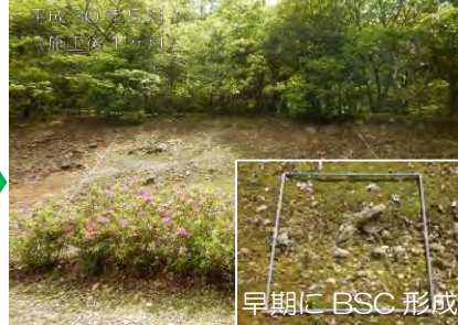
平成30年5月（施工後1ヶ月） 早期にBSC形成 施工半月ほどでBSCが形成され、コケや草本の発芽等も確認されている。
