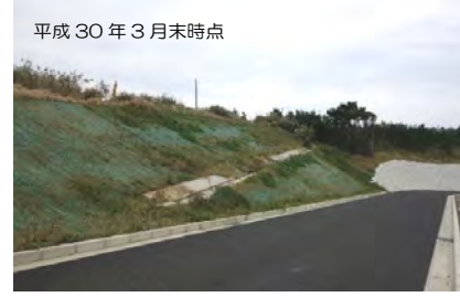
平成30年3月末時点 侵食で基盤が露出・肥料分が流出し、生育不良状態の植生シート工の現場。
