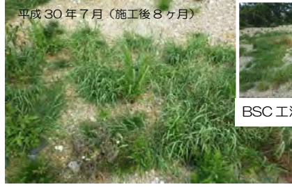
平成30年7月（施工後8ヶ月） BSC工法 BSC工法施工箇所：周辺から侵入した草本が旺盛に繁茂。隙間にも植生侵入。
