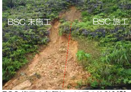
平成30年6月（施工後2ヶ月） BSC未施工 BSC施工 BSC施工の有無についての比較試験。未施工箇所は表面侵食により再度崩落。
