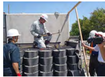
⑥アンカー筋打設
