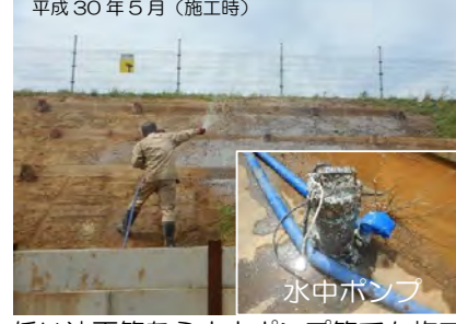
平成30年5月（施工時） 水中ポンプ 低い法面等なら水中ポンプ等でも施工可能（資材濃度等については要調整）。
