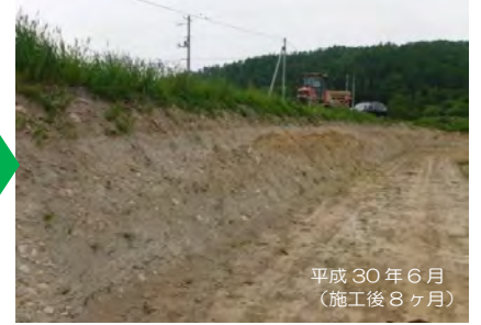
平成30年6月（施工後8ヶ月） 活着前に資材等が融雪により流出したため、BSC形成及び植生侵入はわずか。
