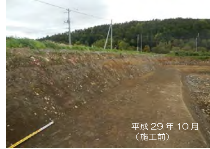
平成29年10月（施工前） 降雪直前の北海道施工箇所。施工後すぐに積雪発生（BSC形成前に積雪）。
