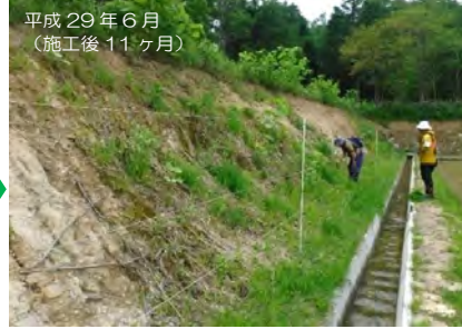
平成29年6月（施工後11ヶ月） 約1箇年経過。降雪・融雪を経ても、BSCが侵食を防止し、植生が再萌芽。
