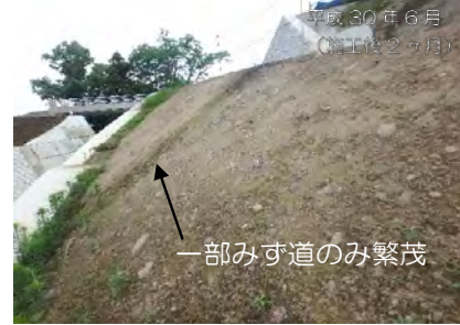
平成30年6月（施工後2ヶ月） 一部みず道のみ繁茂 橋梁直下で降雨がないため、乾燥が強くBSC発達鈍化（みず道では形成）。
