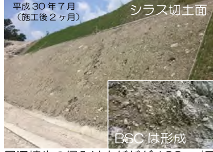
平成30年7月（施工後2ヶ月） シラス切土面 BSCは形成 周辺植生の侵入は未だだが100mm/日以上の降雨を複数経ても侵食なし。
