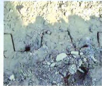
フリクションカッター 使用の引き抜き後
