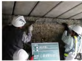
① コンクリート面の清掃
