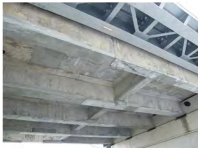
施工例 (床版下面の補修)
