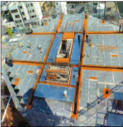
高層マンションスラブ完了状況
