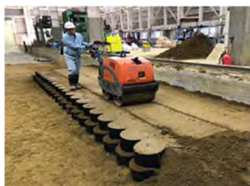
写真-2 ジオセル内外の確実な締固め
