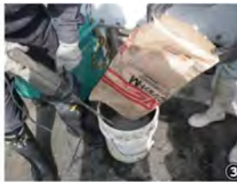
③ 材料の混練 (ハンドミキサー等により攪拌)
