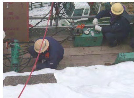
写真-2 従来のリフトオフ試験状
