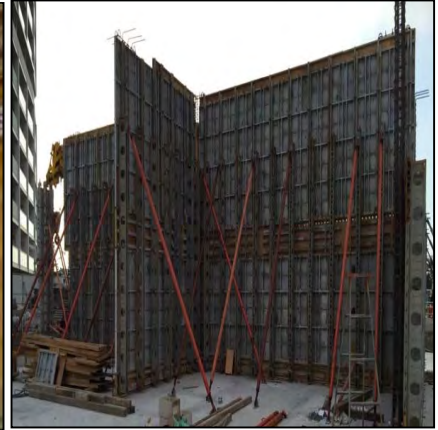
擁壁施工状況
