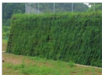
写真-3 完成写真（緑化状況）
