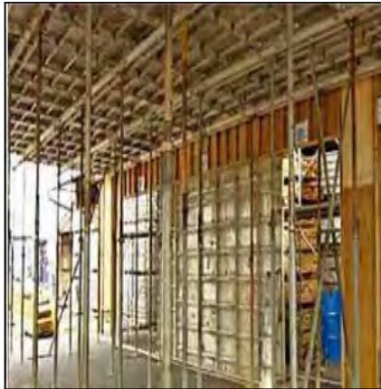
スラブ完了状況（根がらみなど設置）
