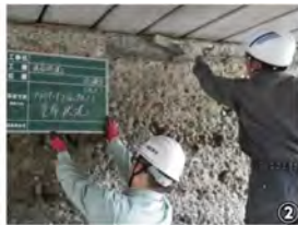
② プライマー処理
