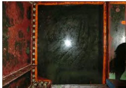
④ 剥離完了
