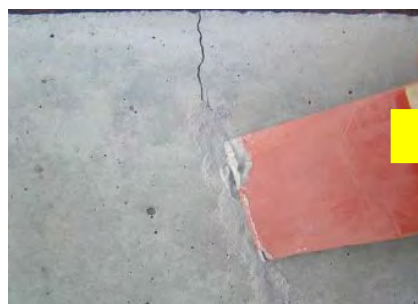
CSパテすり込み状況
