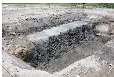
写真-2 改良体試掘状況
