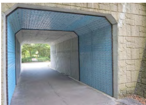
②グリッドメタル設置完了
