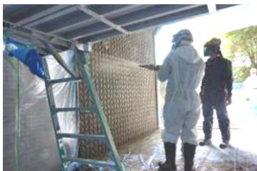
③ポリマーセメント吹付状況
