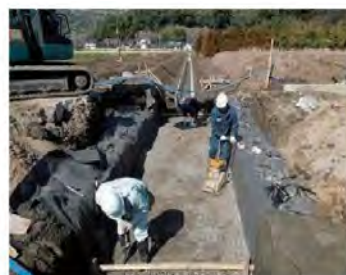
3 中詰材均し・締めめ
