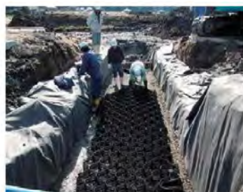
2 不織布(吸出し防止材)・グラウンドセル設置
