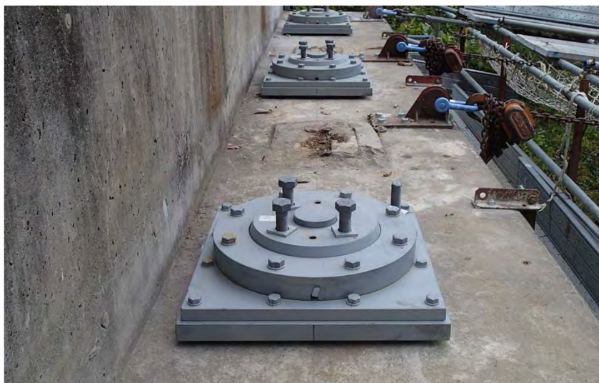
写-1 支承据え付け状況
