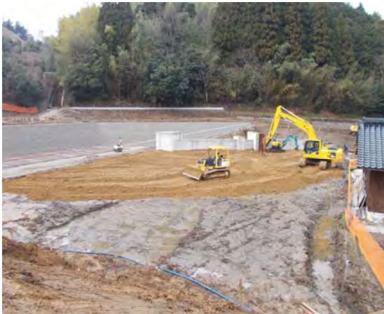
「水質対策:ため池堤体改良」
