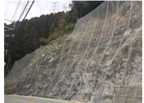
写真2 施工実績(八女市矢部村)
