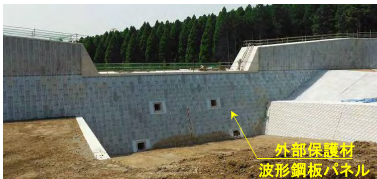
【不透過型砂防堰堤】
