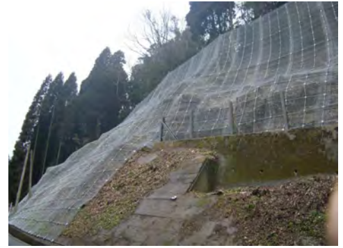
写真1 施工実績(日田市上津江町)
