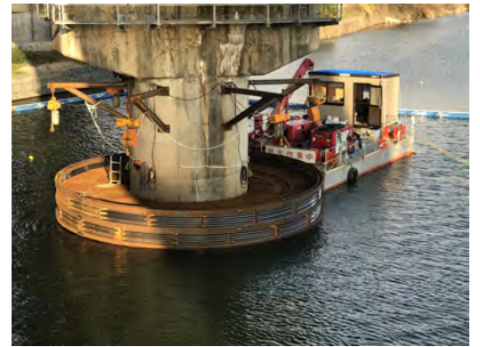
写真—2 円形組立状況
