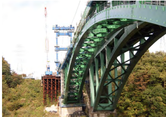
太田切川橋梁(全景)
