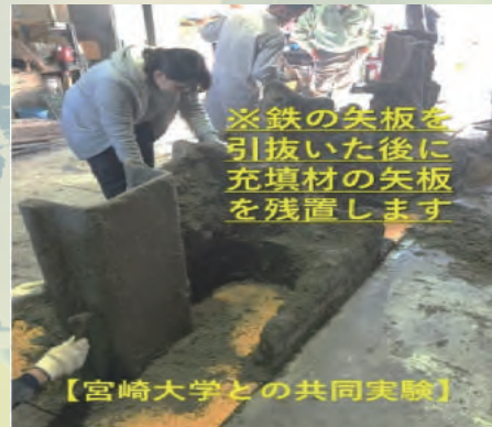
充填材はすぐに固まり、且つ地中障害物にならないように強度もコントロールされています。
