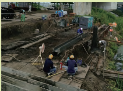
➔ ため池での施工 (H杭引抜き)
