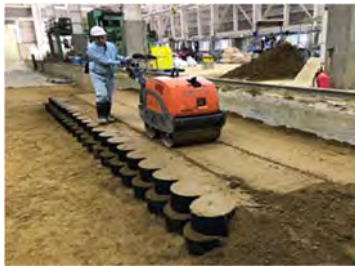
写真-2 ジオセル内外の確実な締固め
