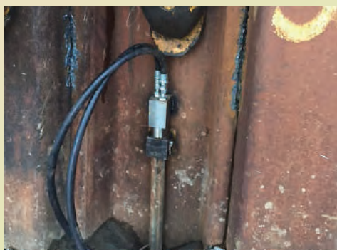
➔ 特殊充填管設置状況
