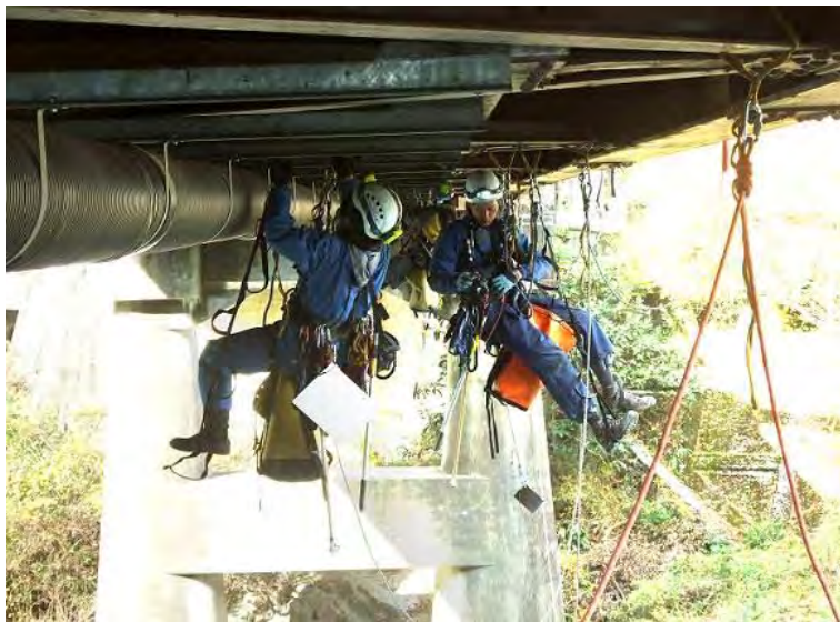
一般国道定期点検状況
