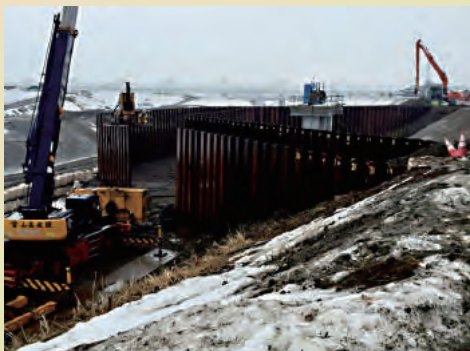
➔ 堤防での施工
