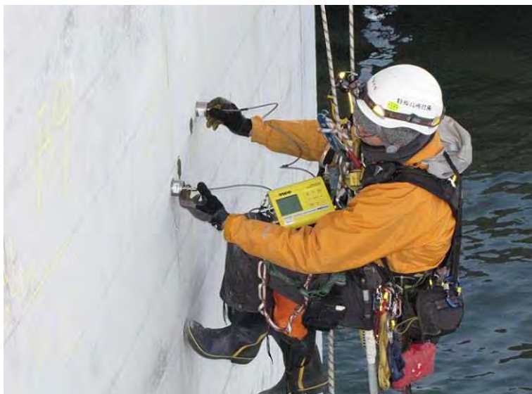
超音波計測器によるコンクリートひび割れ深さ計測状況
