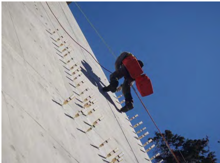
ひび割れ補修(低圧注入工法)状況
