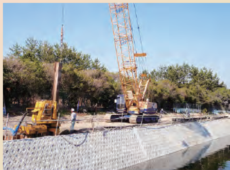
➔ 河川での施工
