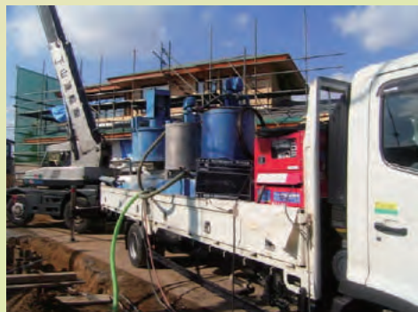
➔ 車上プラント設備
