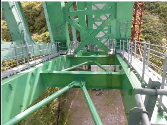
二重鋼管ダンパー設置状況
