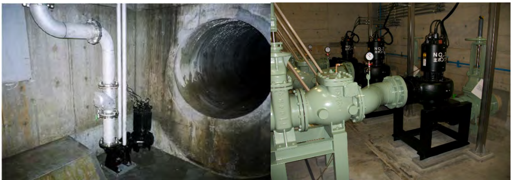
(東京都内某雨水貯留施設)
