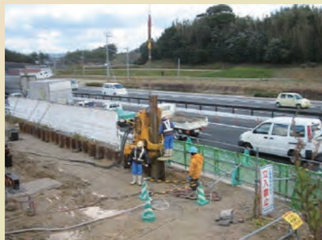
➔ 交通量の多い道路際の施工
