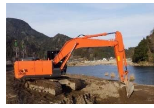
ICT建設機械施工(3次元MG)による掘削
