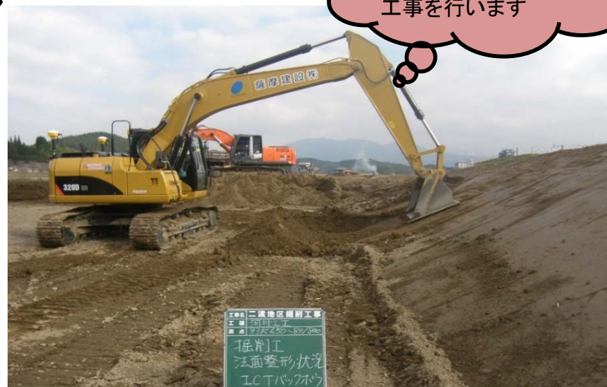
▲丁張りレス作業
