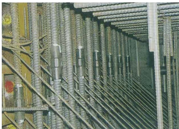
地下構造物施工例
