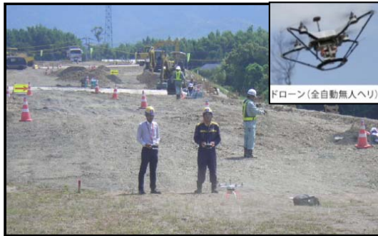
UAV測量の検証を行い。現場での実効性を確認
