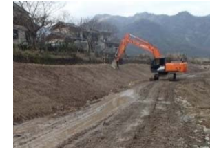
ICT建設機械施工(3次元MG)による掘削
