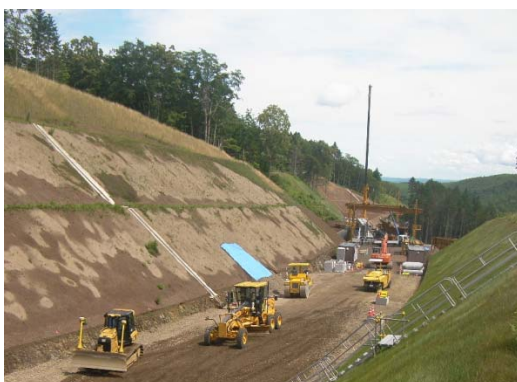
施工現場全景
