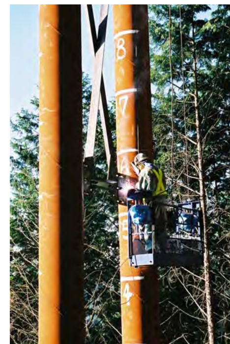
8. 伸縮梁取付 完了
