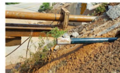
⑥システム施工後排水
