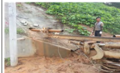
③掘削機械（ケーシング）：30m
