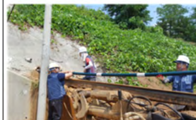
⑤ドレインパイプ水平排水管施工
