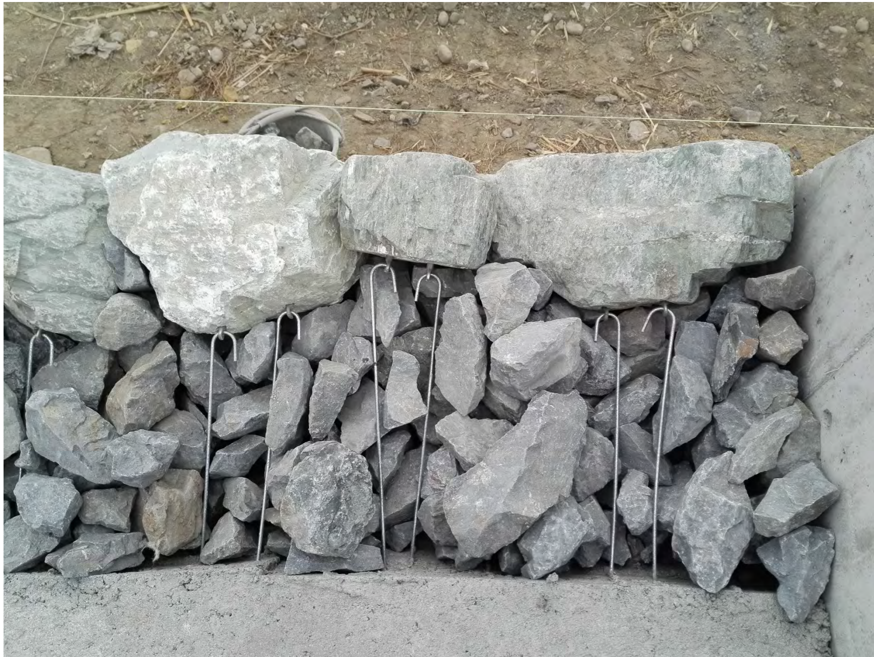
メッキ鉄線ダブルバーション。 水流の激しい場所、水かさがすぐに増す川。
