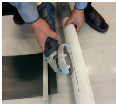
ドレインパイプへベルトを連結部分に穴をあける
