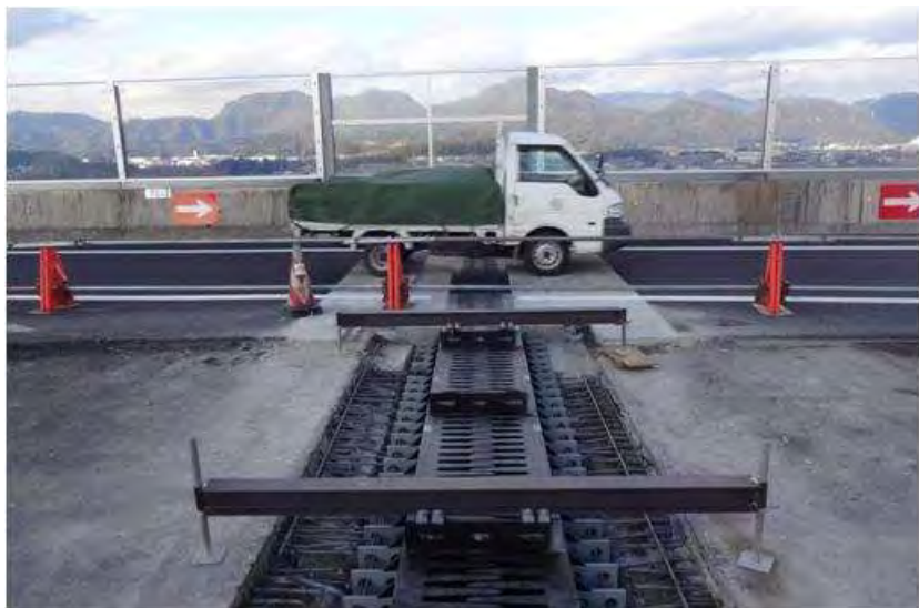
NEXCO中日本 A橋
