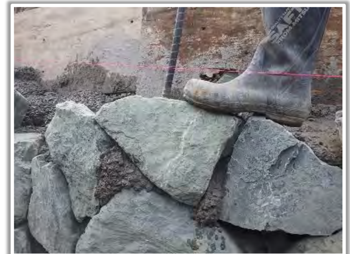
③石の隙間に コンクリートを充填
