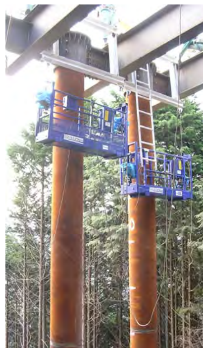
7. ゴンドラ 設置
