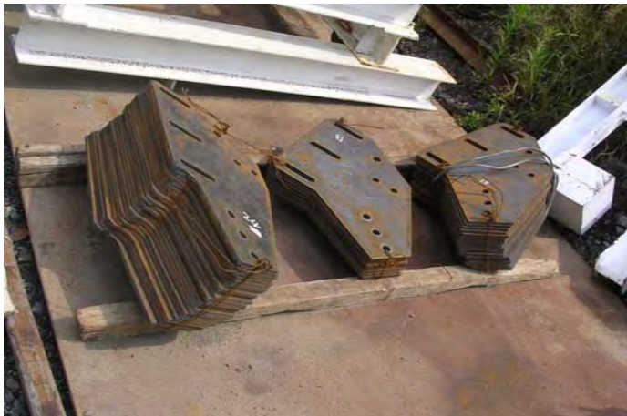
1. 工場製作部材搬入
