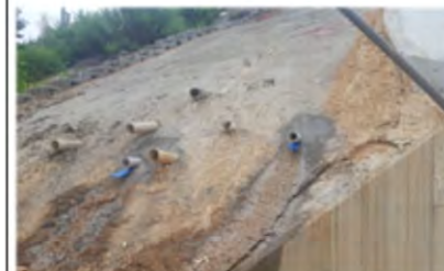
⑦挿入部分仕上げ
