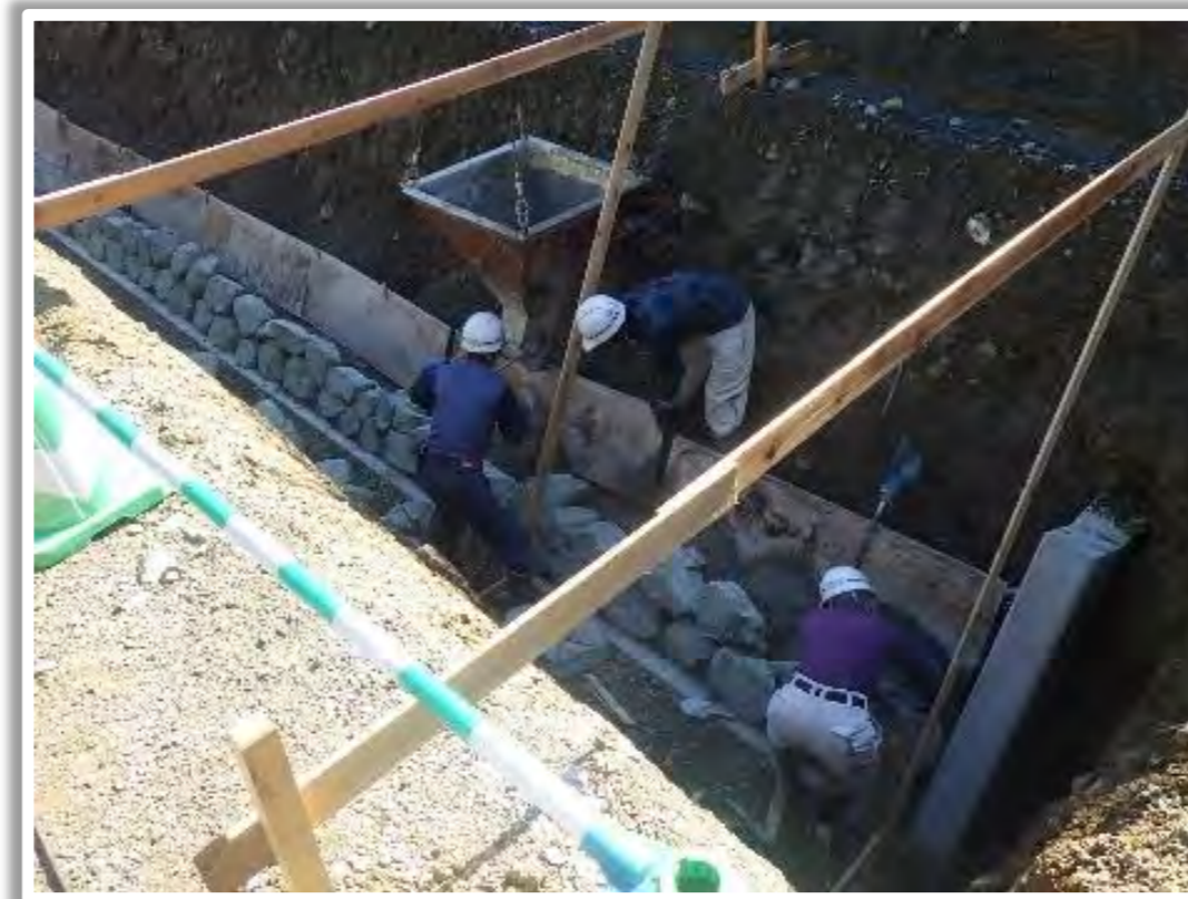
②石の裏側に コンクリートを打設
