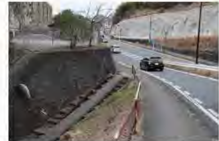
街路灯が倒れた事故現場付近。倒れた街路灯が道路脇に寄せられている = 8日午後4時54分、福山市伊勢丘
