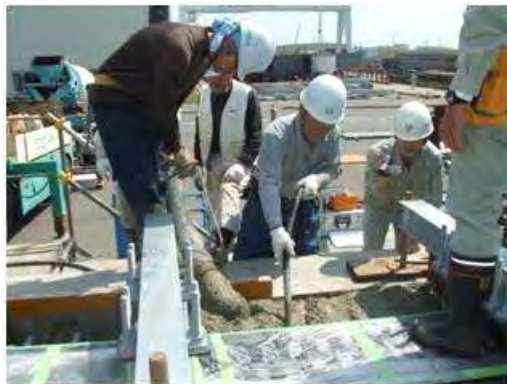
鹿島工場内 施工試験
