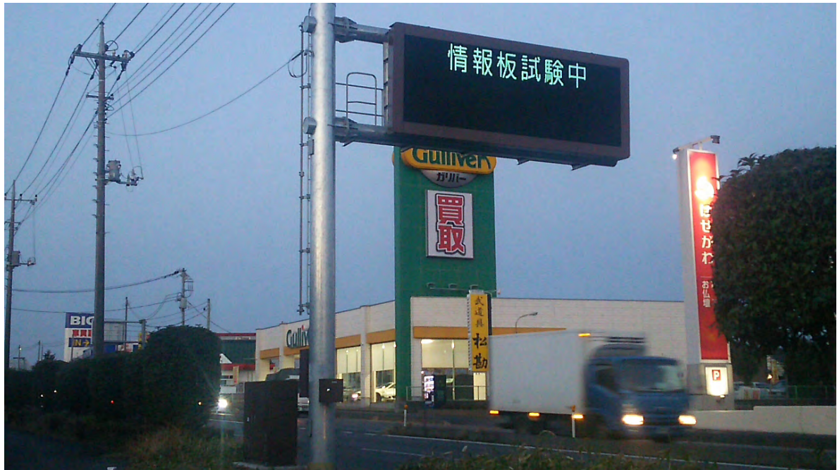
国道情報板のバックアップ電源（稼働中）
