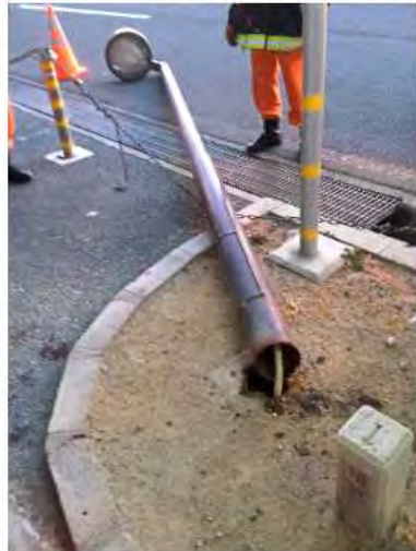
根元から倒れた照明柱 = 大阪府池田市提供
