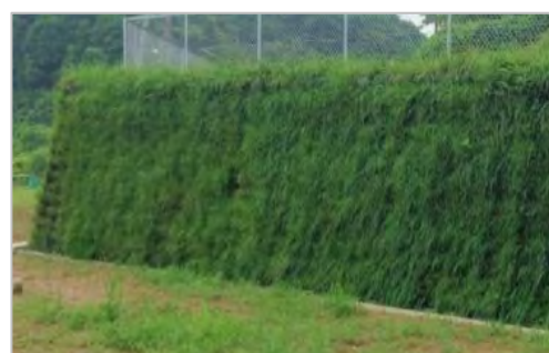
写真-3 完成写真（緑化状況）
