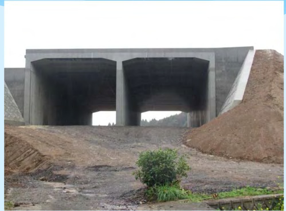
九州地方整備局八代河川国道事務所 熊本3号水俣IC部構造物設置外工事 (内空幅 (7.125m+7.125m)、内空高さ : 5.7m)
