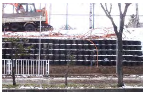
写真-2 凍上性確認試験（北海道北見市）
