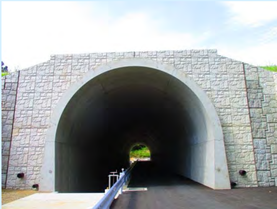
九州地方整備局熊本河川国道事務所 九州横断道 山都地区 (内空幅7.30m、内空高さ：7.85m)
