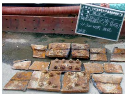
写真-5 切羽で切断・回収された鋼材
