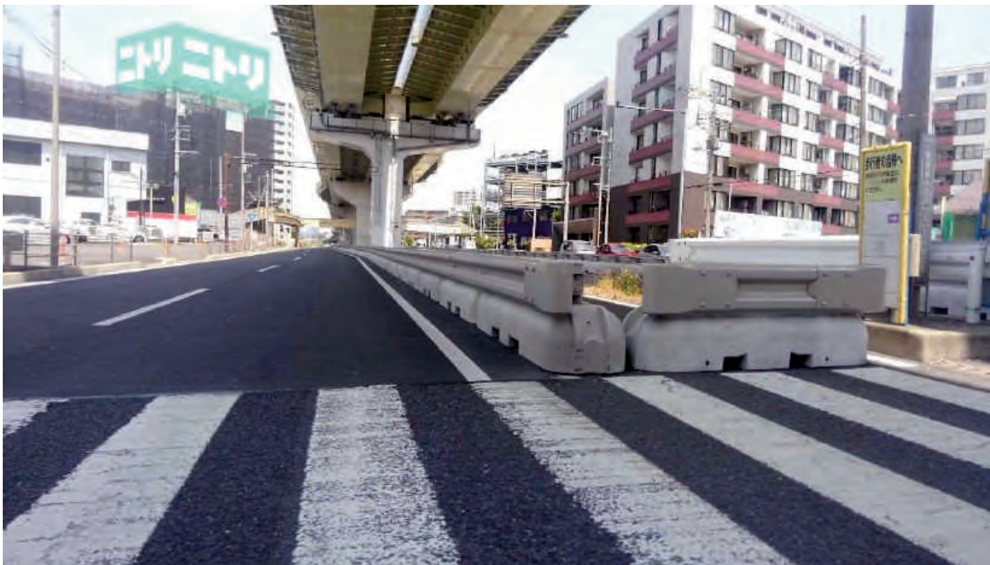
川崎国道事務所 発注工事（東京都町田市）
