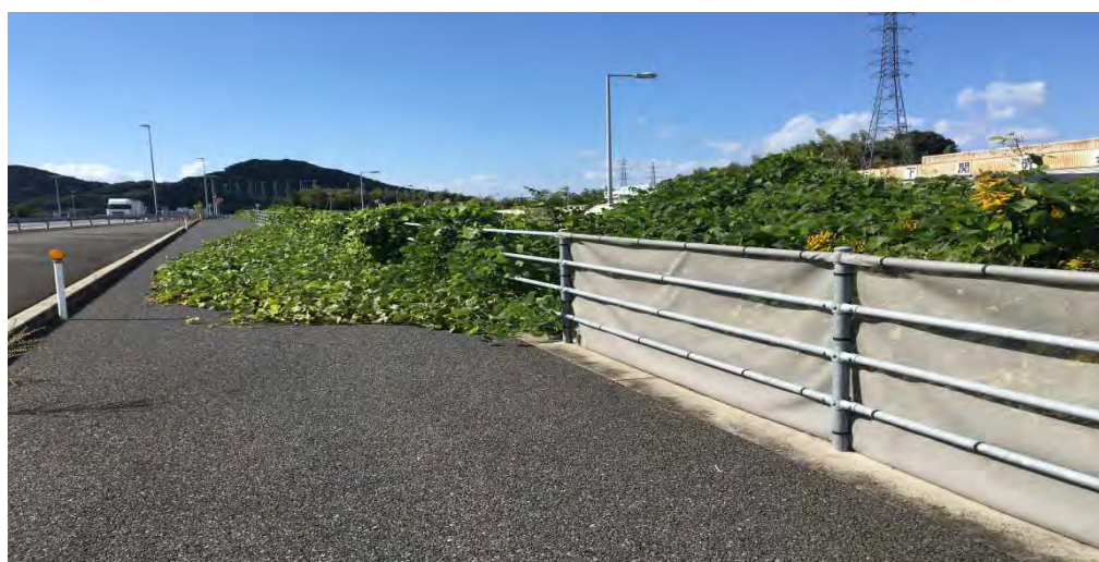
施工箇所と未施工箇所の比較
