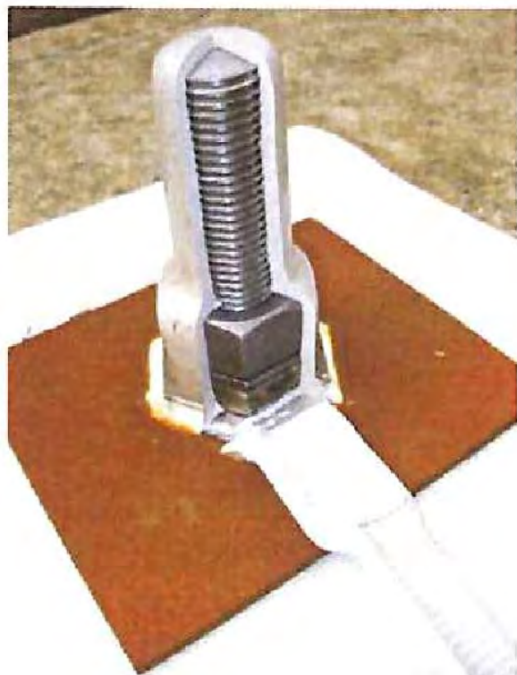
施工後、3年6ヶ月後の状況
