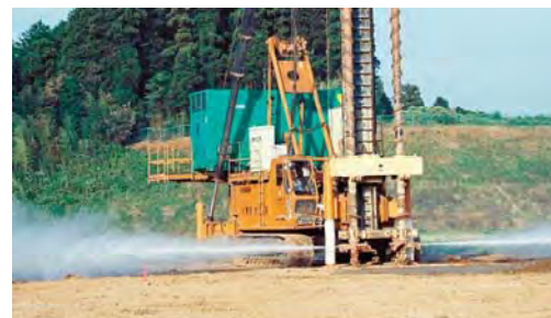
SDM-Fit 高圧噴射状況
