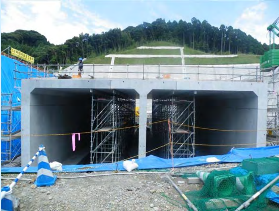
九州地方整備局佐賀国道事務所 佐賀497号府招長田地区函渠工事 (内空幅 (6.2m+6.2m)、内空高さ : 5.7m)
