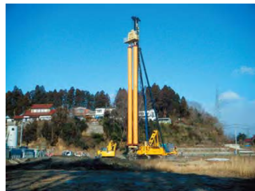
SDM-FitⅣ施工状況
