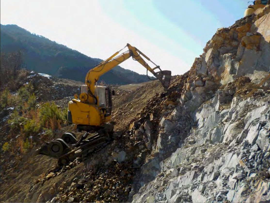
法面の掘削を行うロッククライミングマシン（RCM）
