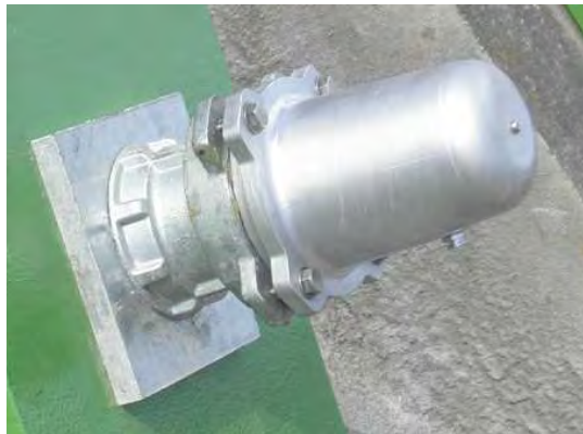
窓付止水具設置
