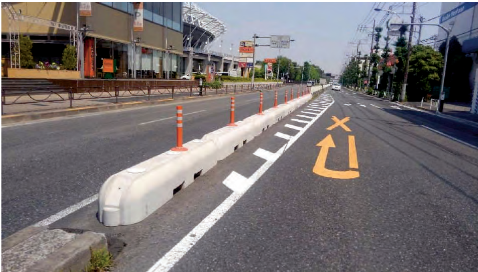
相武国道事務所 発注工事
