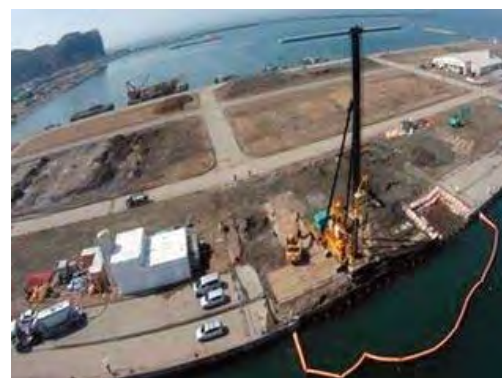
SDM-FitⅡ施工状況
