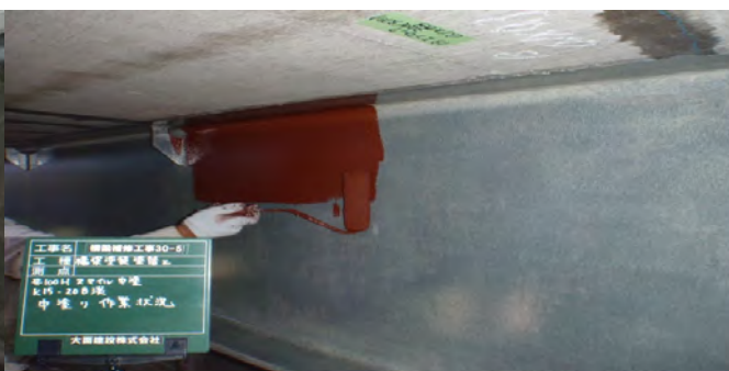
工程3(2日目) 中塗り「弱溶剤形ふっ素樹脂塗料用中塗り」
