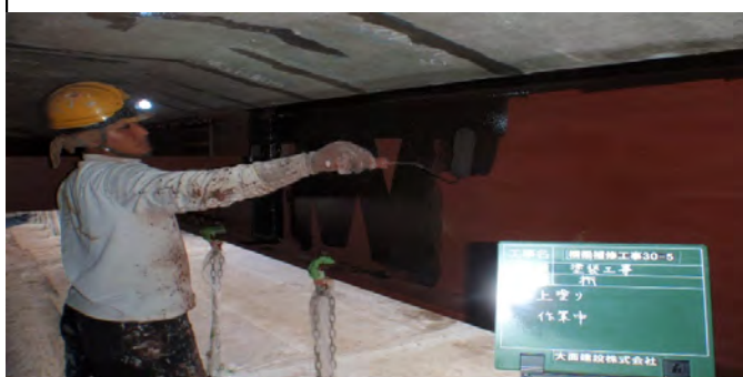
工程4(3日目) 上塗り「弱溶剤形ふっ素樹脂塗料上塗り」
