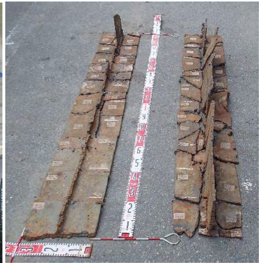
撤去されたH形鋼
