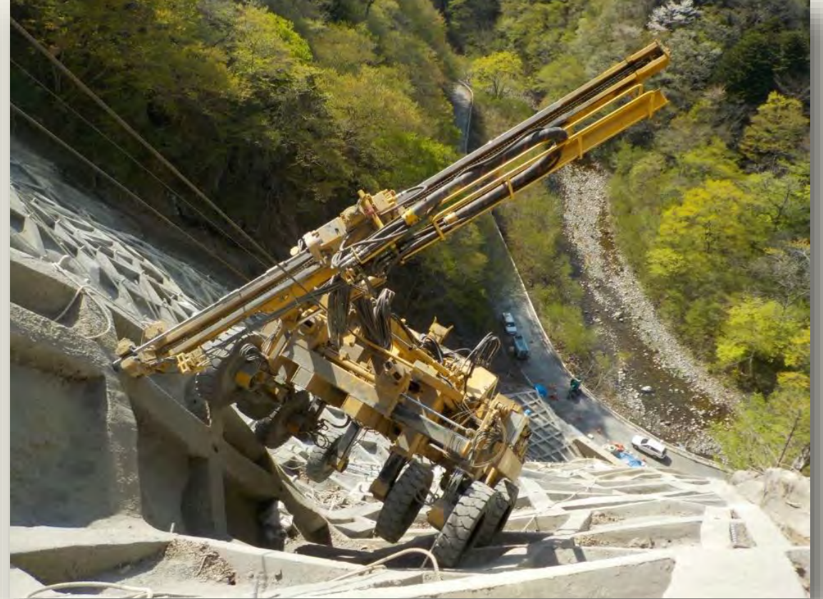
法面や急斜面のロックボルト工事を行うアンカーロックマシン（ARM）
