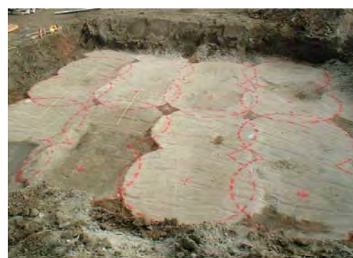
SDM-Fit改良体状況
