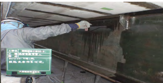
工程2-1(1日目) 脱脂洗浄「サビバリヤー脱脂剤」
