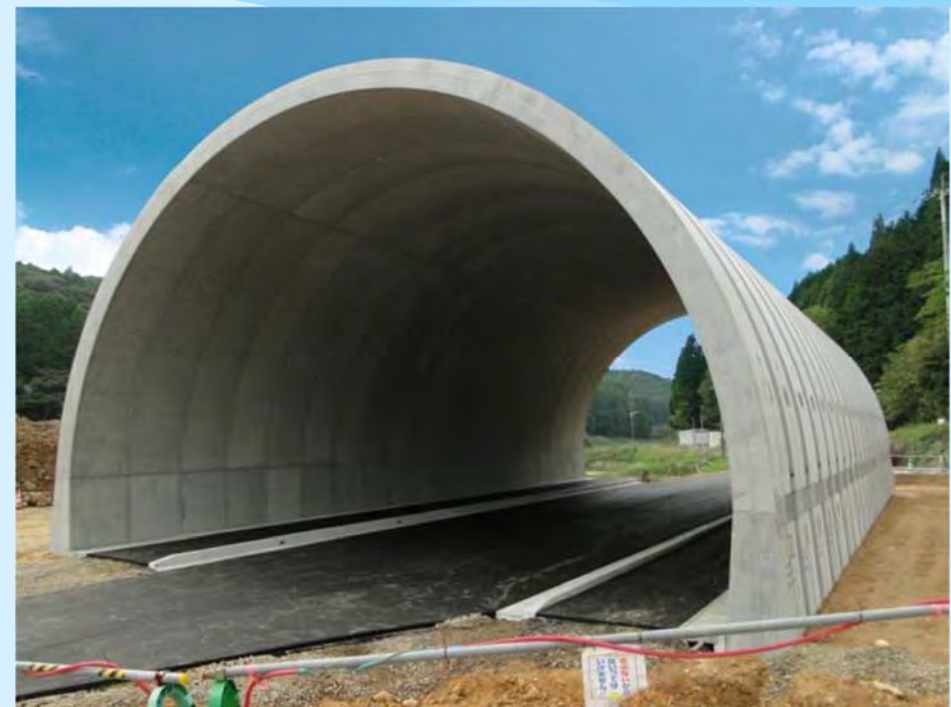
九州地方整備局佐賀国道事務所 佐賀497号乙房地区函渠工事 (内空幅12.30m、内空高さ：8.15m)
