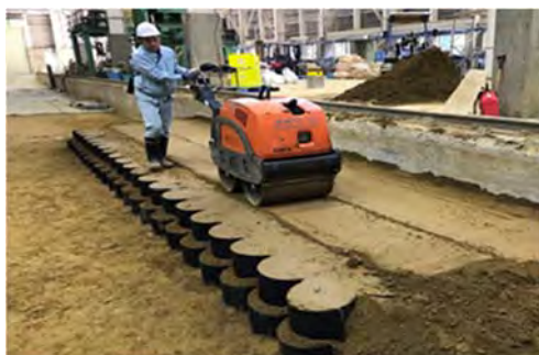
写真-1 ジオセル内外の確実な締固め
