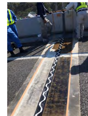
2) プライマー塗布
