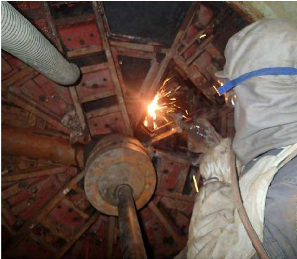
H形鋼切断状況
