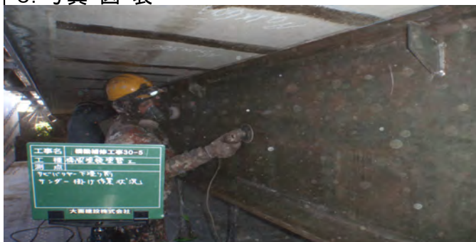
工程1(1日目) 素地調整(素地調整程度3種以上)
